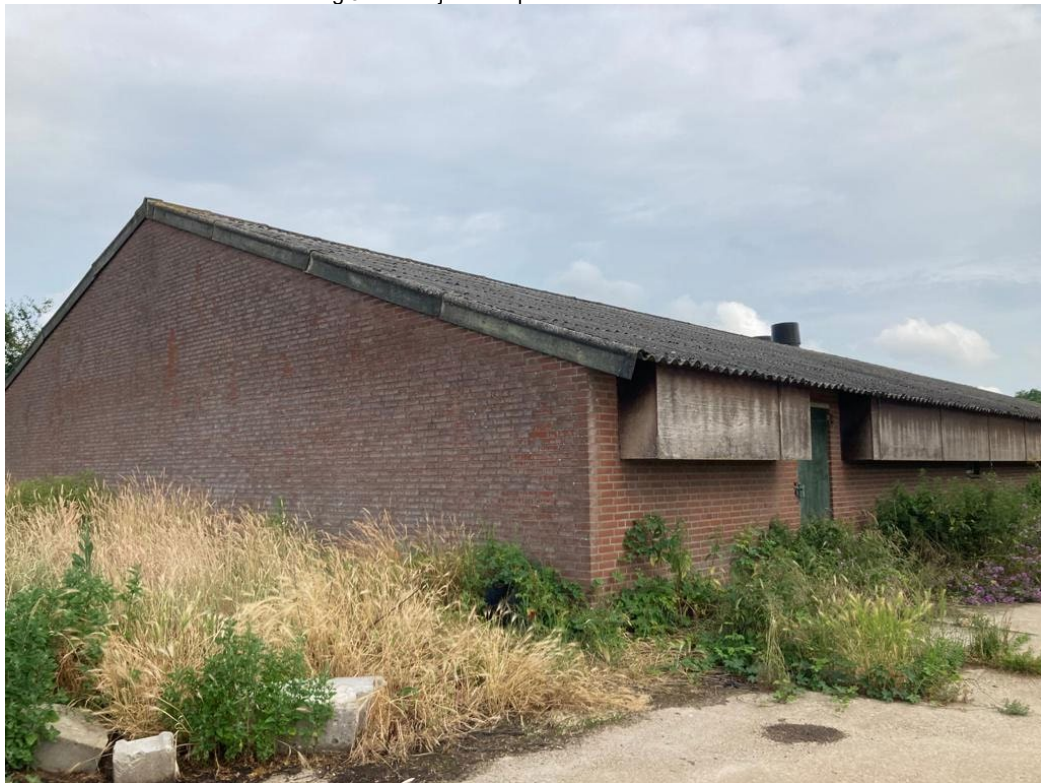
• Afbeelding 3: buitenzijde te slopen varkensstal
