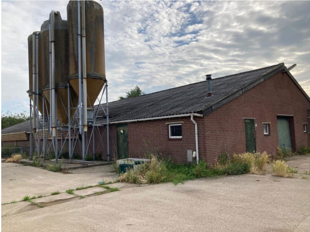
• Afbeelding 4: buitenzijde te slopen varkensstal
