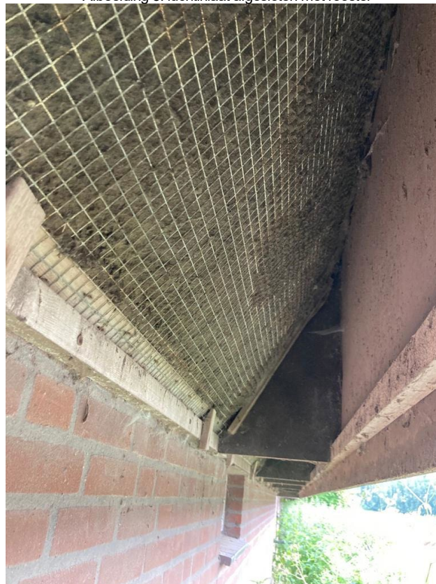
• Afbeelding 5: luchtinlaat afgesloten met rooster
