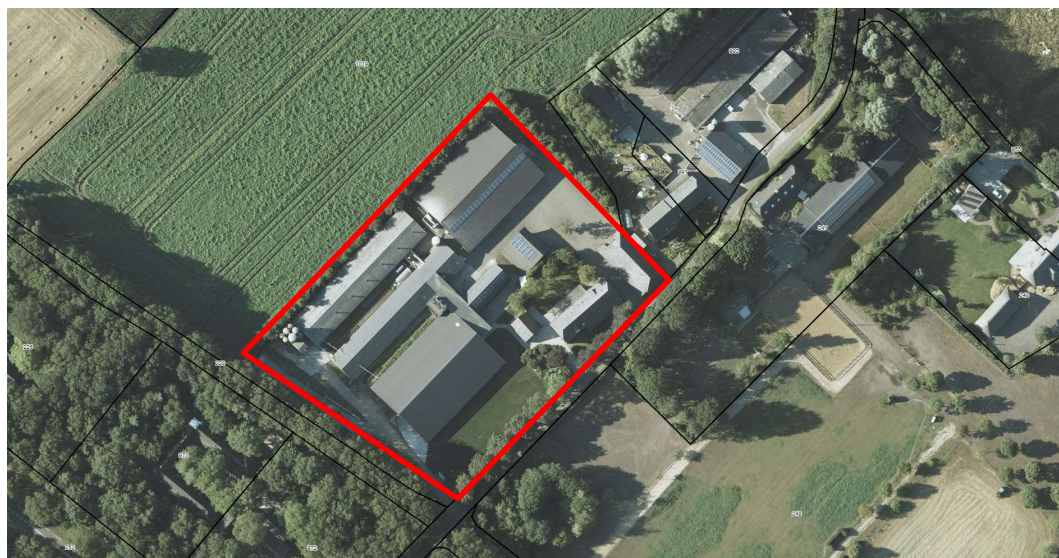
Figuur 1.2: luchtfoto met begrenzing plangebied (bron: Street Smart by Cyclomedia)
