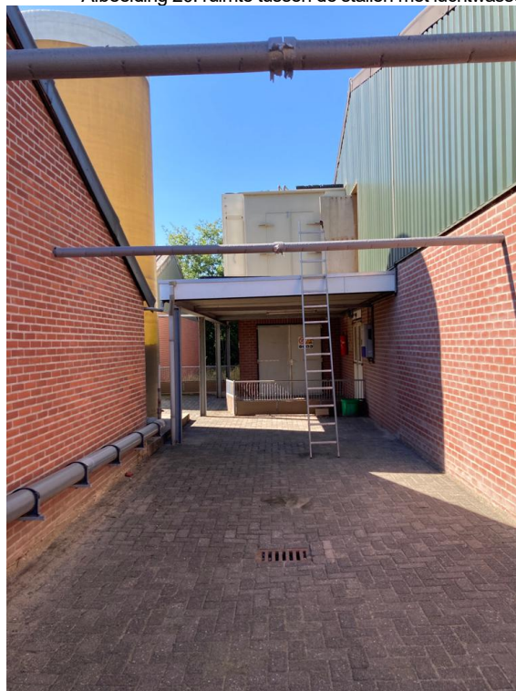
• Afbeelding 20: ruimte tussen de stallen met luchtwasser
