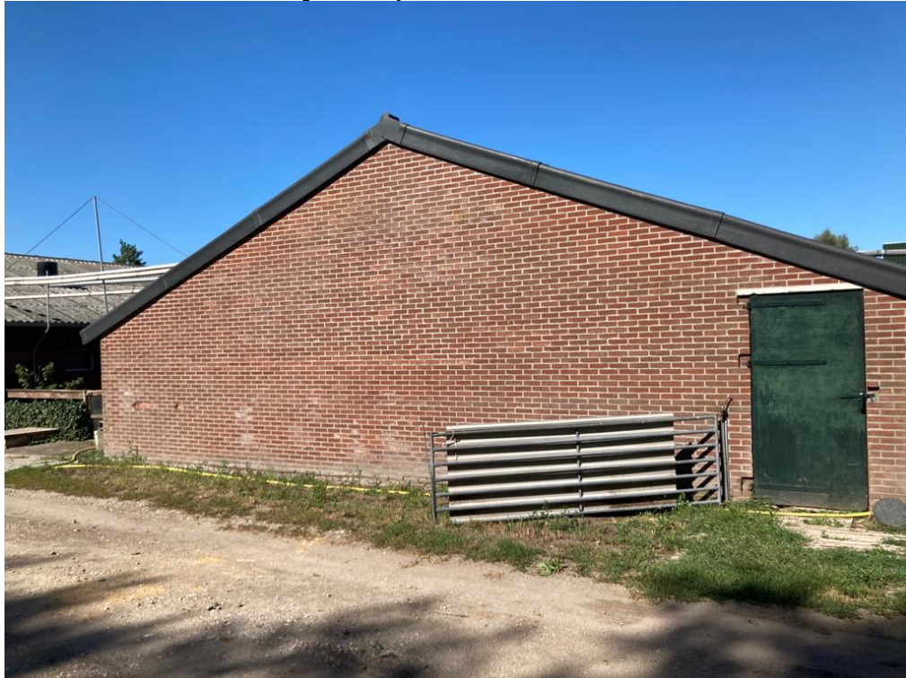
• Afbeelding 9: achterzijde varkensstallen
