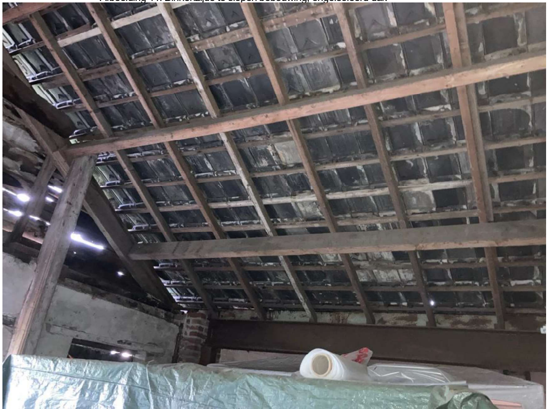
• Afbeelding 11: Binnenzijde te slopen bebouwing, ongeïsoleerd dak
