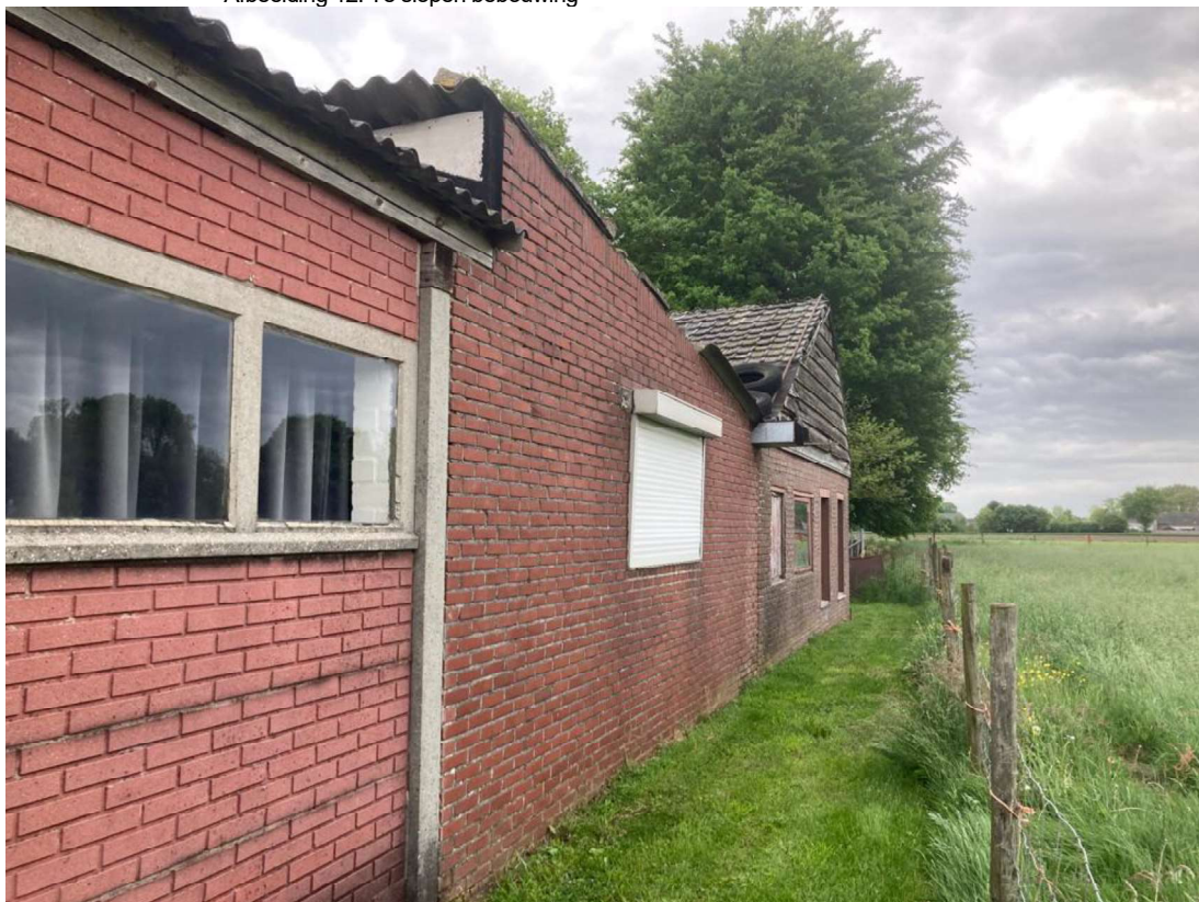
• Afbeelding 12: Te slopen bebouwing
