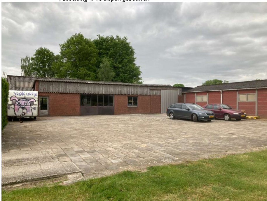
• Afbeelding 4: Te slopen gebouwen
