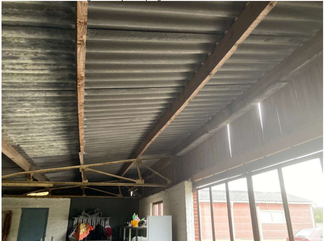
• Afbeelding 7: Binnenzijde te slopen gebouw
