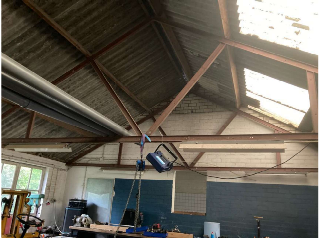
• Afbeelding 8: Binnenzijde te slopen gebouw
