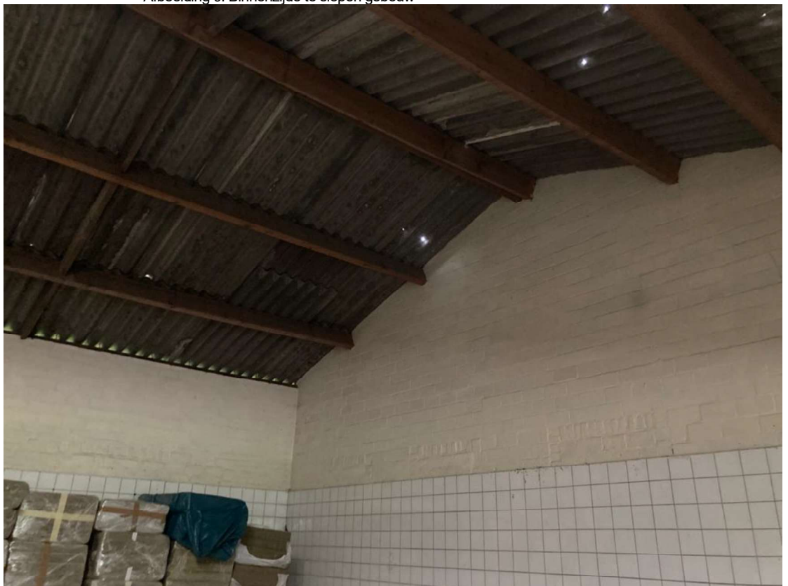
• Afbeelding 9: Binnenzijde te slopen gebouw
