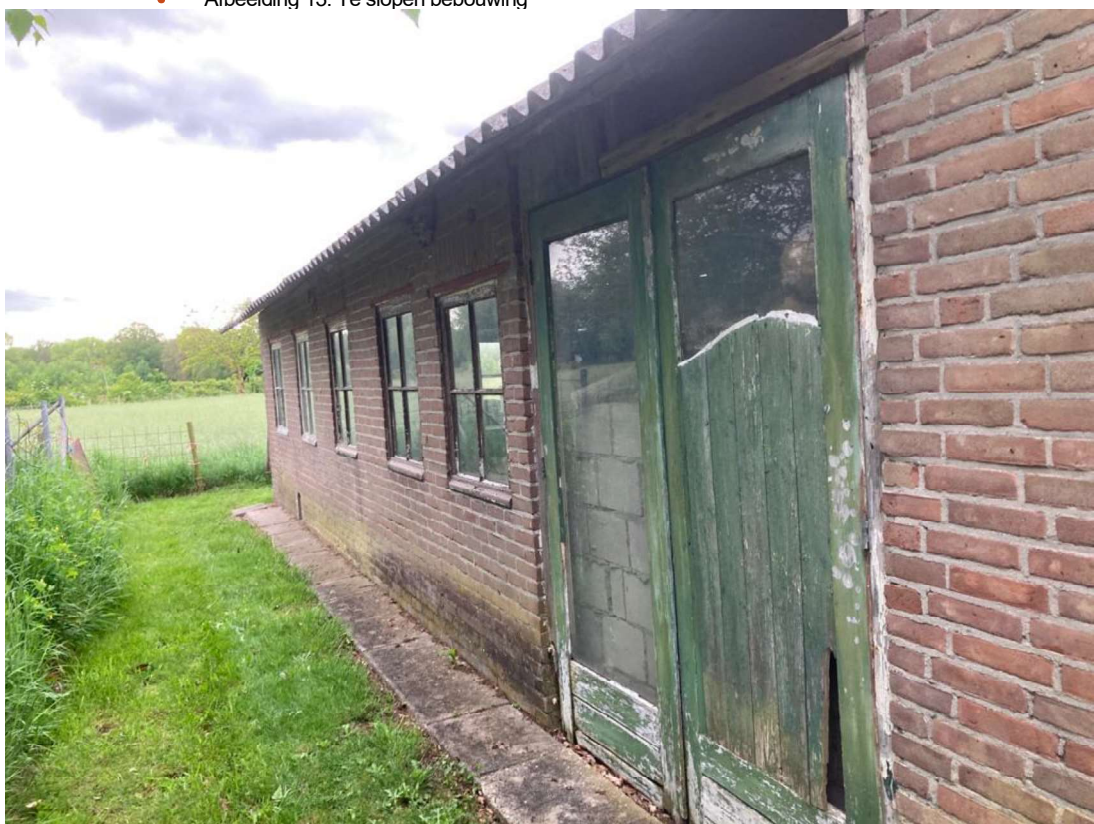
• Afbeelding 13: Te slopen bebouwing
