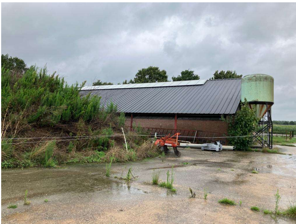
• Afbeelding 19: achterzijde te slopen rundveestal met daarvoor verharding
