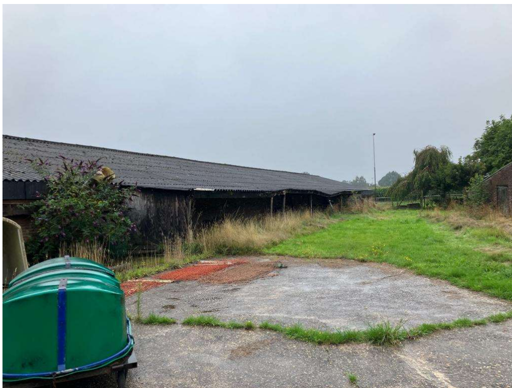
• Afbeelding 15: te slopen varkensstal
