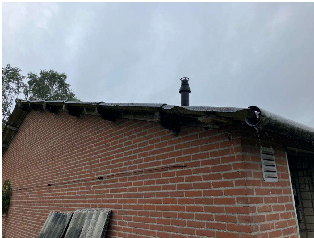
• Afbeelding 16: kopgevel te slopen varkensstal
