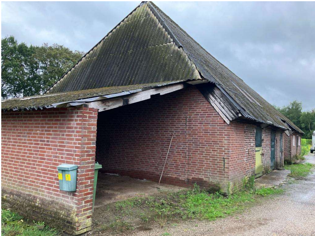
• Afbeelding 3: Te renoveren kapschuur
