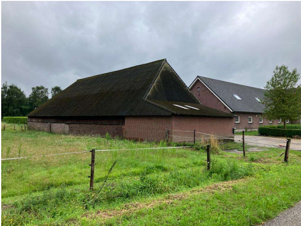
• Afbeelding 11: te renoveren kapschuur met daarachter te splitsen woning
