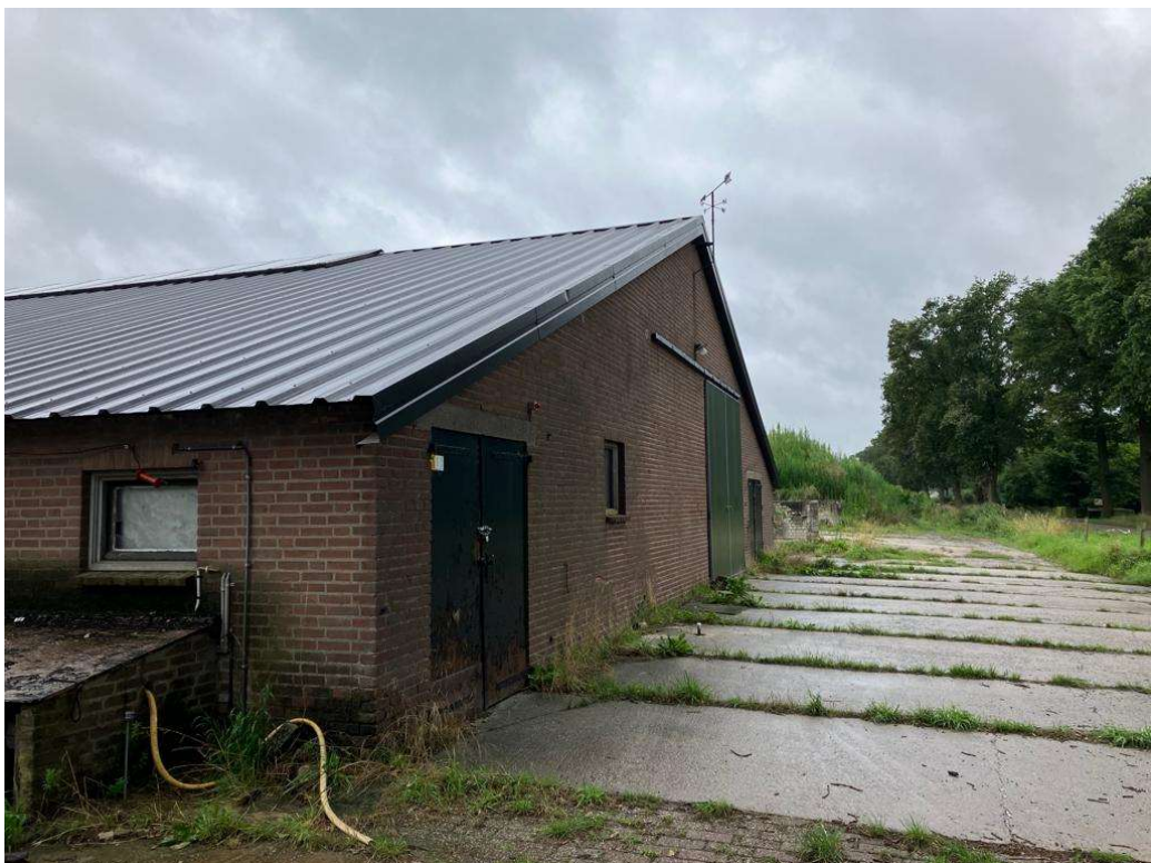
• Afbeelding 24: voorgevel te slopen rundveestal, dak voorzien van geïsoleerde sandwichplaten
