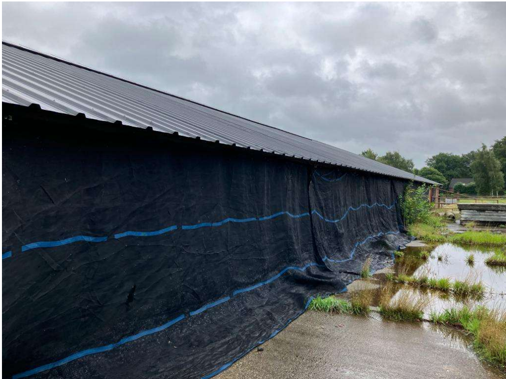
• Afbeelding 21: Zijgevel rundveestal, dicht gemaakt met windbreekgaas
