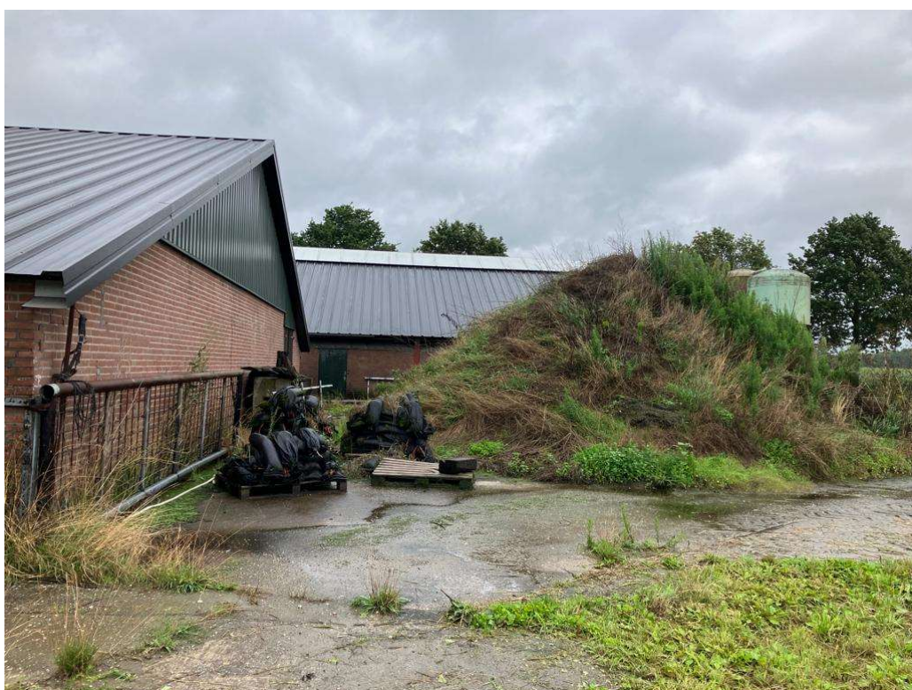
• Afbeelding 20: achterzijde rundveestal met verharding en kuilplaat
