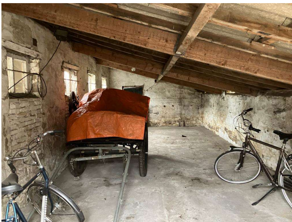
• Afbeelding 10: binnenzijde te slopen schuur, steens muren, ongeïsoleerde golfplaten
