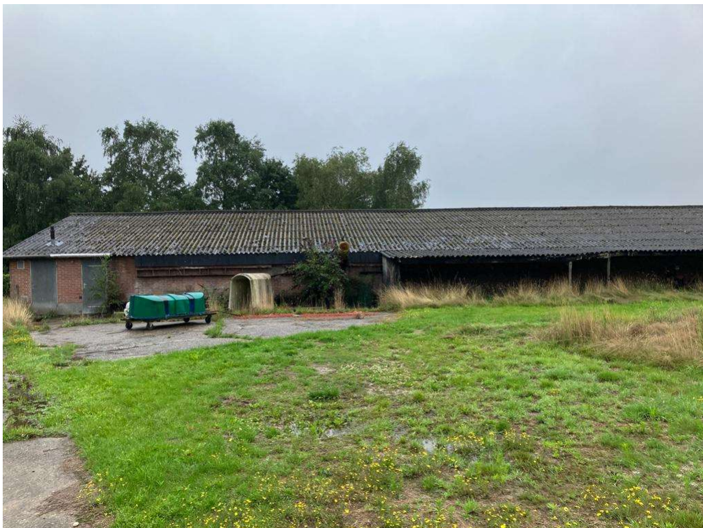
• Afbeelding 14: te slopen varkensstal
