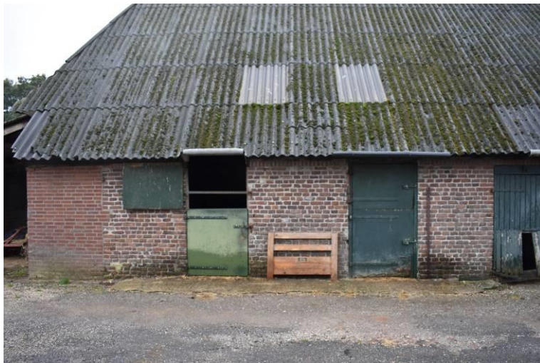
Linkerzijde van de voorgevel van de schaapskooi met oorspronkelijk metselwerk.
