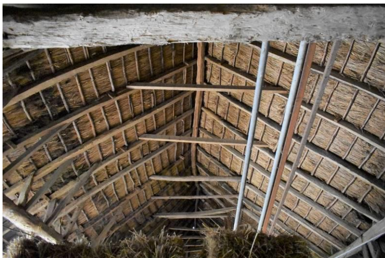
Sporenkap met daarover rietlatten en de oorspronkelijke rieten dakbedekking.
