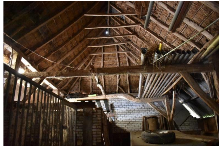
Oorspronkelijke constructie in de schaapskooi met op de achtergrond vernieuwd metselwerk.
