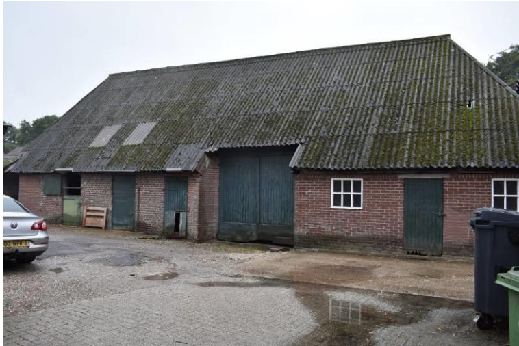
Voorgevel van de schaapskooi.
