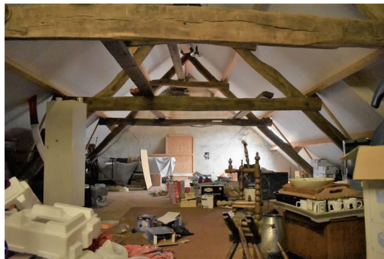
Dakconstructie met A-spanten boven het bedrijfsgeboude.
