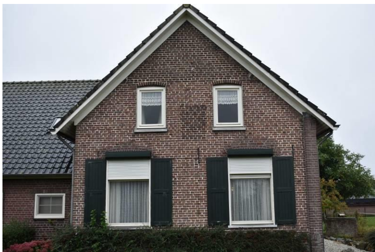
Linkerzijgevel van het woongedeelte.
