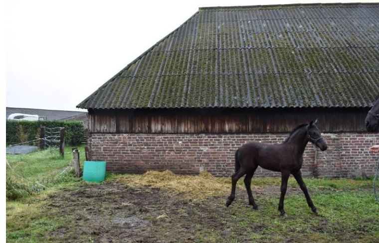
Linkerzijde van de achtergevel van de schaapskooi met oorspronkelijk metselwerk.
