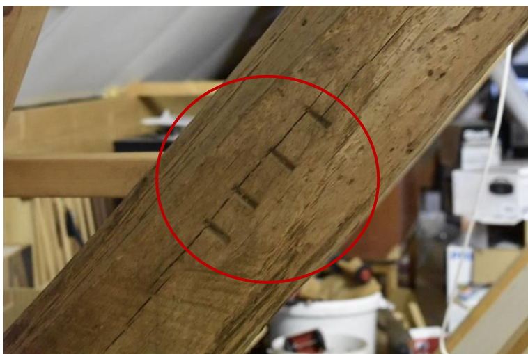
Telmerk IIII in een van de spanten.
