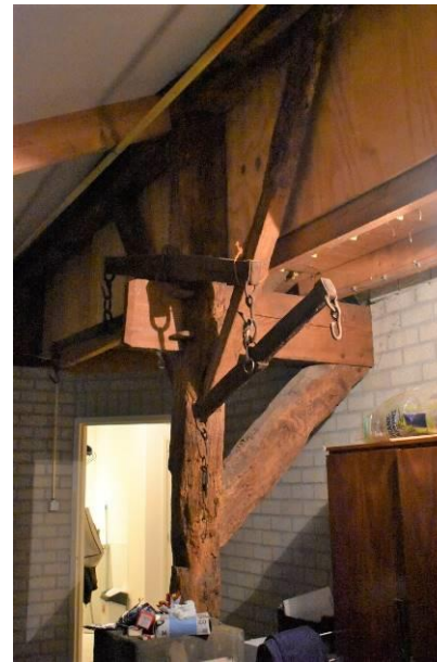
Ankerbalkgebint in de voormalige varkensstal.
