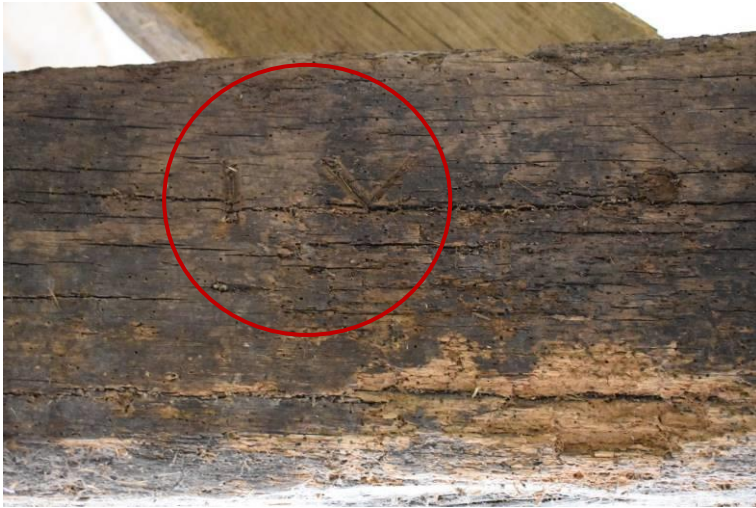
Telmerk IV in een van de spanten.
