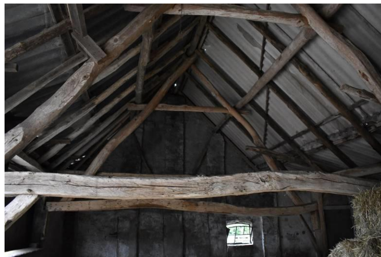
A-spanten in het interieur van de schop.
