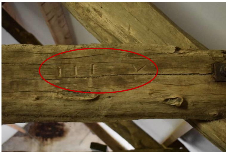
Telmerk IIIV in een van de spanten.
