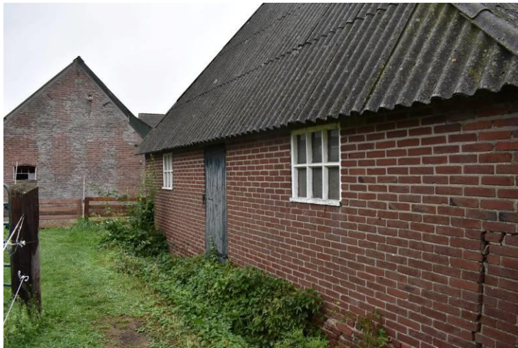
Rechterzijgevel van de schaapskooi, welke volledig vernieuwd is.
