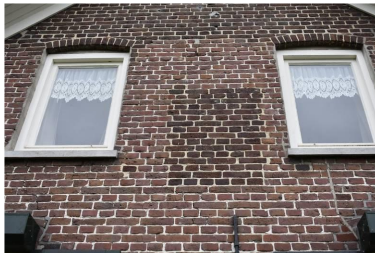
Vensters op de verdieping in linkerzijgevel.
