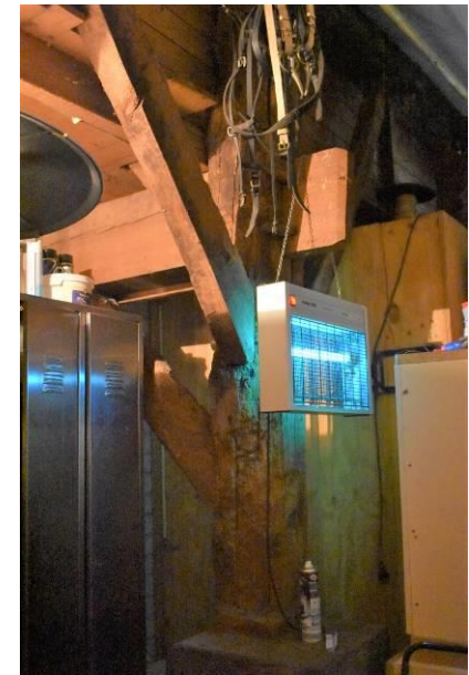
Ankerbalkgebint in de voormalige varkensstal.
