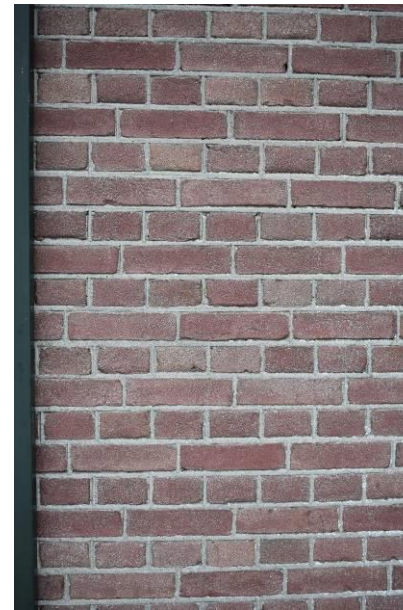
Metselwerk in kruisverband.
