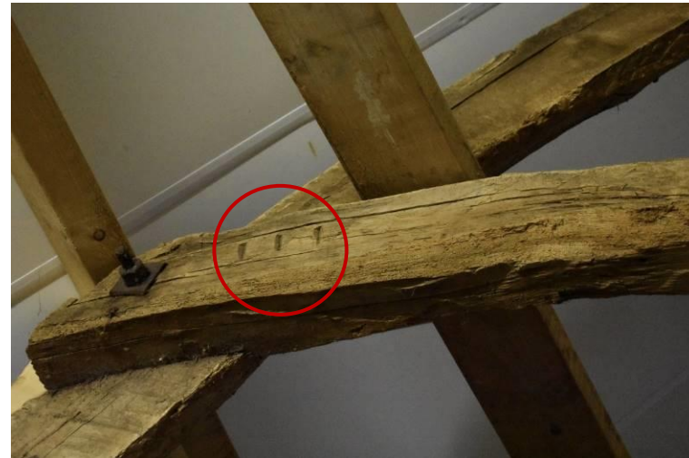
Telmerk III in een van de spanten.
