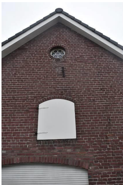
Luik en rondvenster in de achtergevel.
