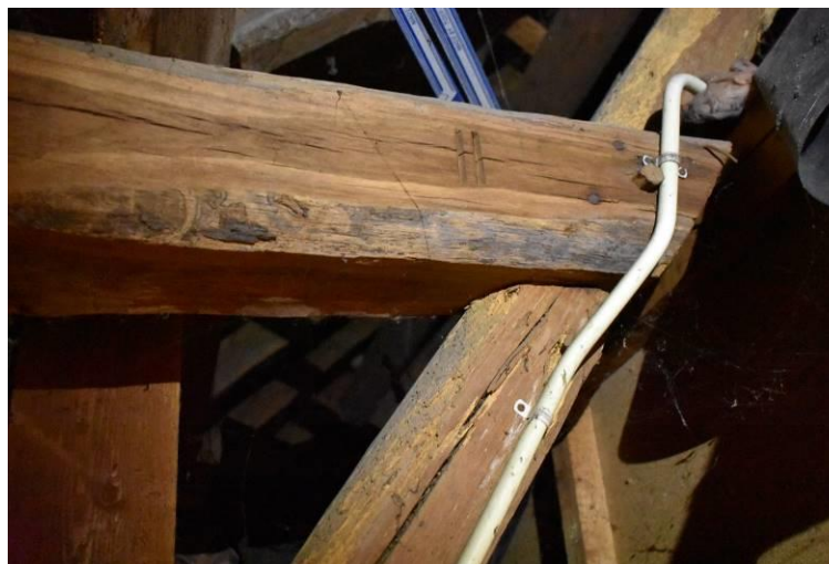
Dakconstructie van het woongedeelte met telmerk II.
