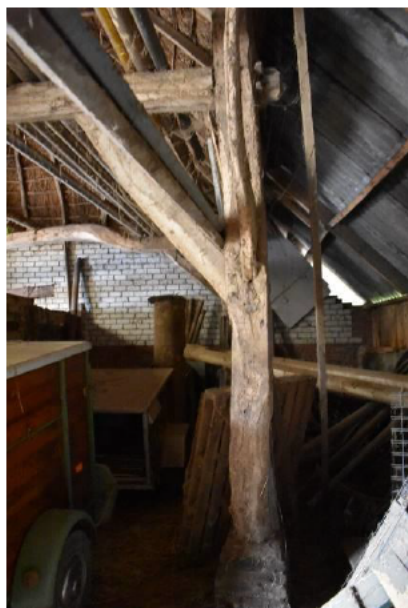
Oorspronkelijke staander op gemetselde poer.
