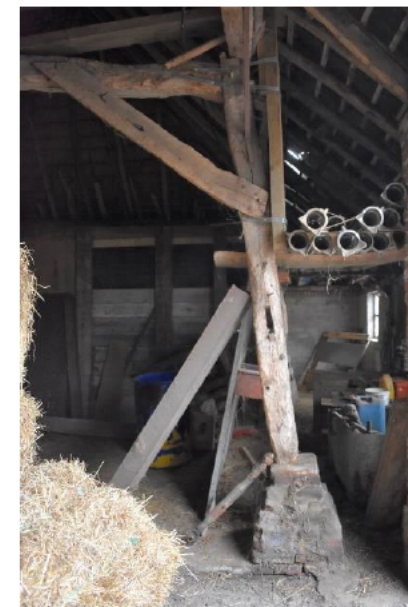
Ankerbalkgebint in de schaapskooi.
