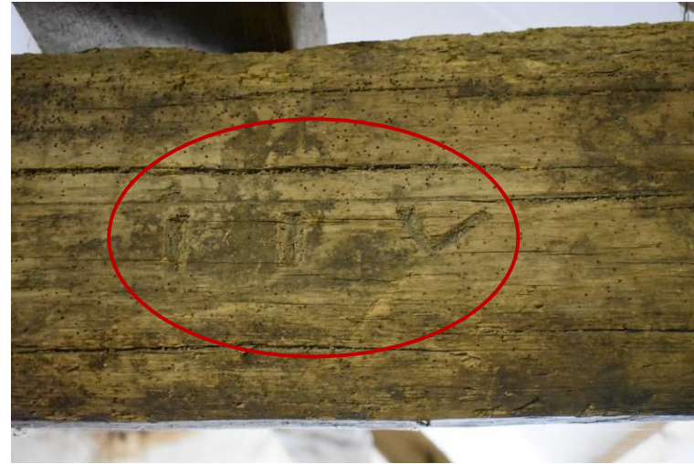
Telmerk IIV in een van de spanten.
