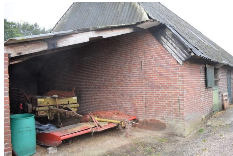
Linkerzijgevel van de schaapskooi, welke volledig vernieuwd is.
