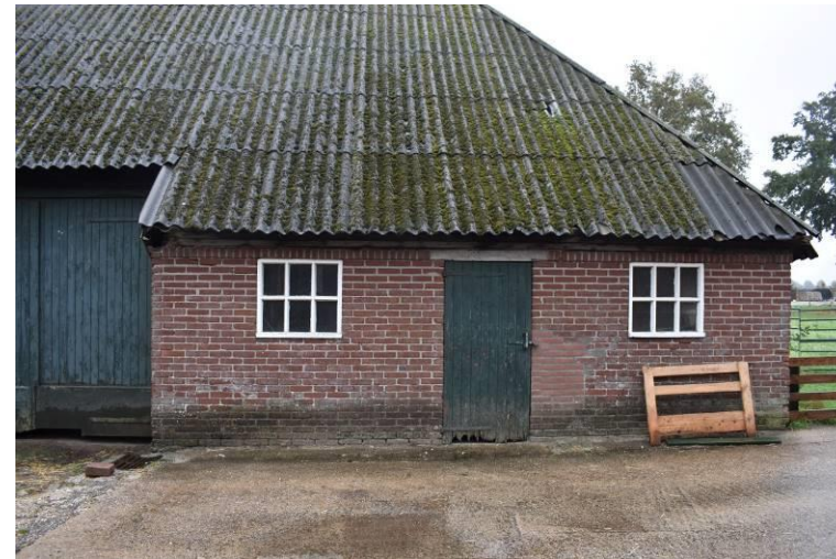
Rechterzijde van de voorgevel van de schaapskooi met vernieuwd metselwerk.
