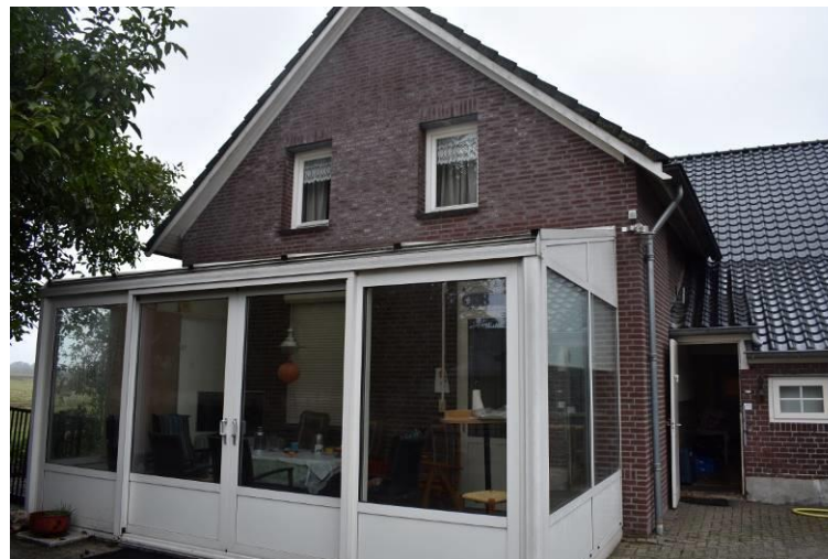
Serre tegen de nieuw opgetrokken rechterzijgevel.
