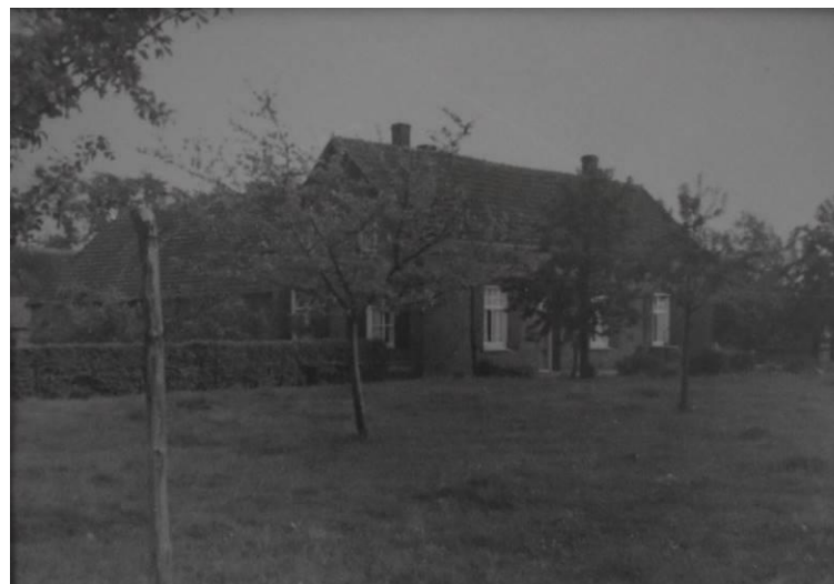
Historische foto van Driehoek 11 vóór het optrekken van de nieuwe gevels.
