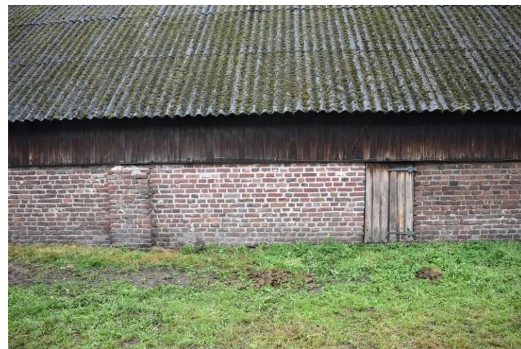
Oorspronkelijk metselwerk in de achtergevel.
