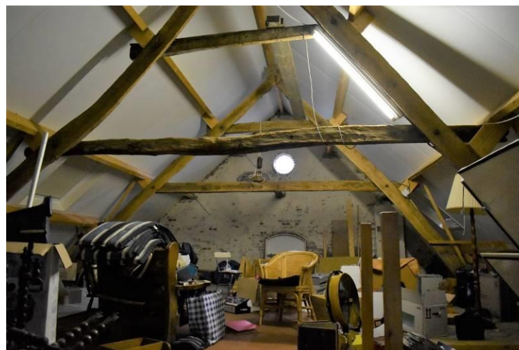
Dakconstructie met A-spanten boven het bedrijfsgeboude.
