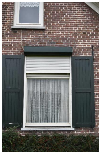
Venster in linkerzijgevel.
