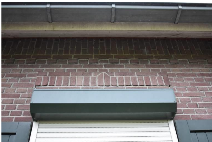
Siermetselwerk boven gevelopeningen in voorgevel.
