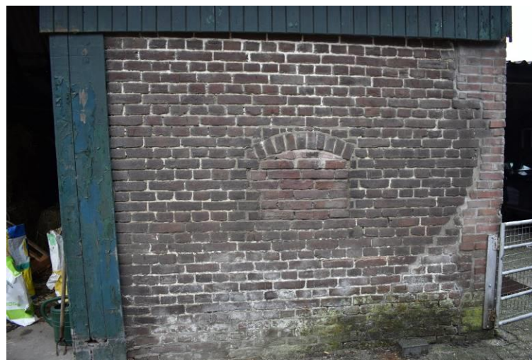
Restant oorspronkelijk metselwerk in voorgevel.
