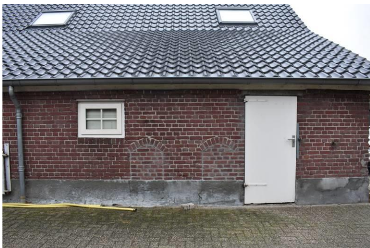
Dichtgemetselde varkensdeurtjes in de rechterzijgevel.
