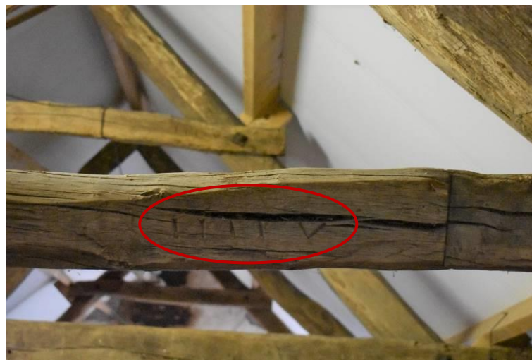
Telmerk IIIIV in een van de spanten.
