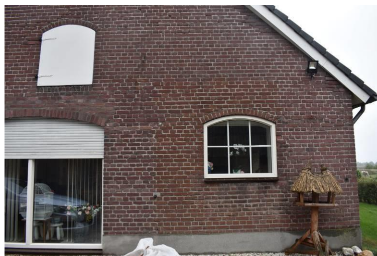
Sporen van een dichtgemetselde deuropening in de achtergevel.
