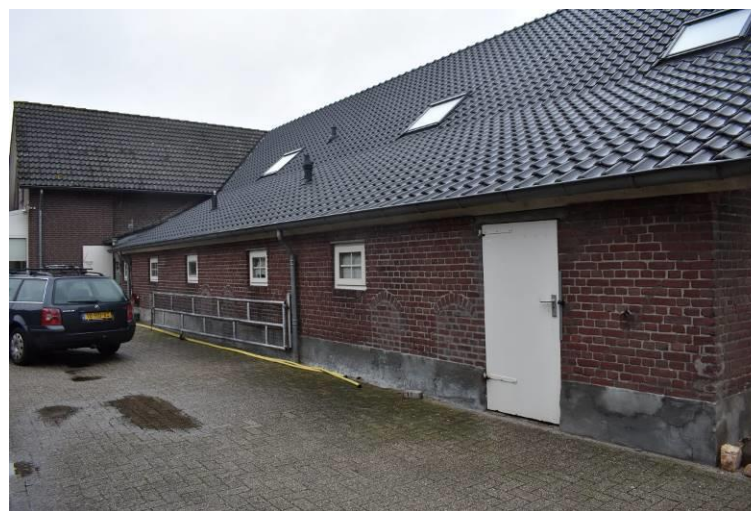
Rechterzijgevel van het bedrijfs gedeelte.
