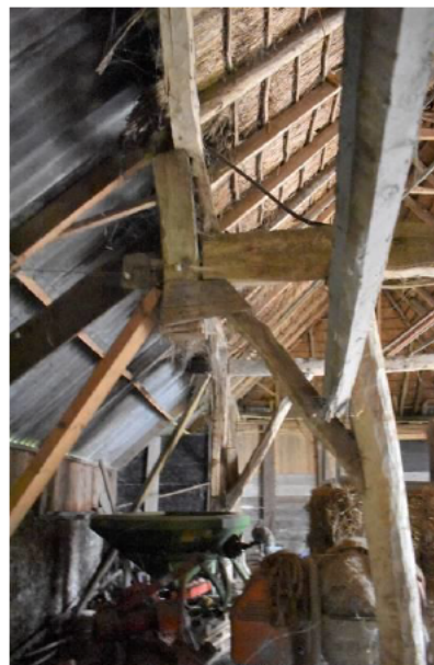
Constructie in de schaapskooi.
