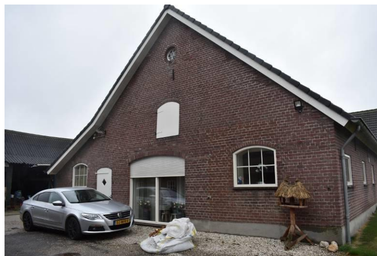
Achtergevel van het bedrijfsgedeelte.
