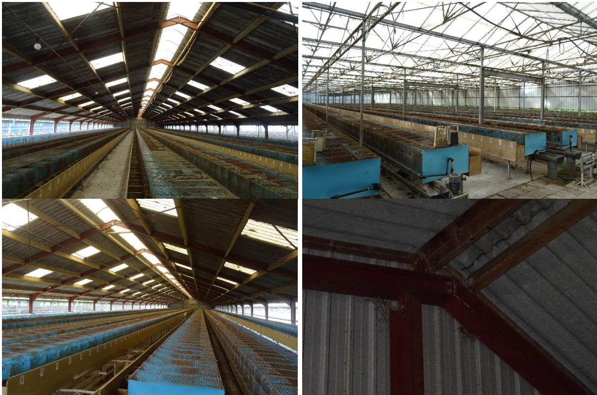
Afbeelding 11 t/m 14: daken te slopen stallen en te verplaatsen loods zonder dakbeschot. Bron: R.J.L. Bijvelds 02-08-2021
