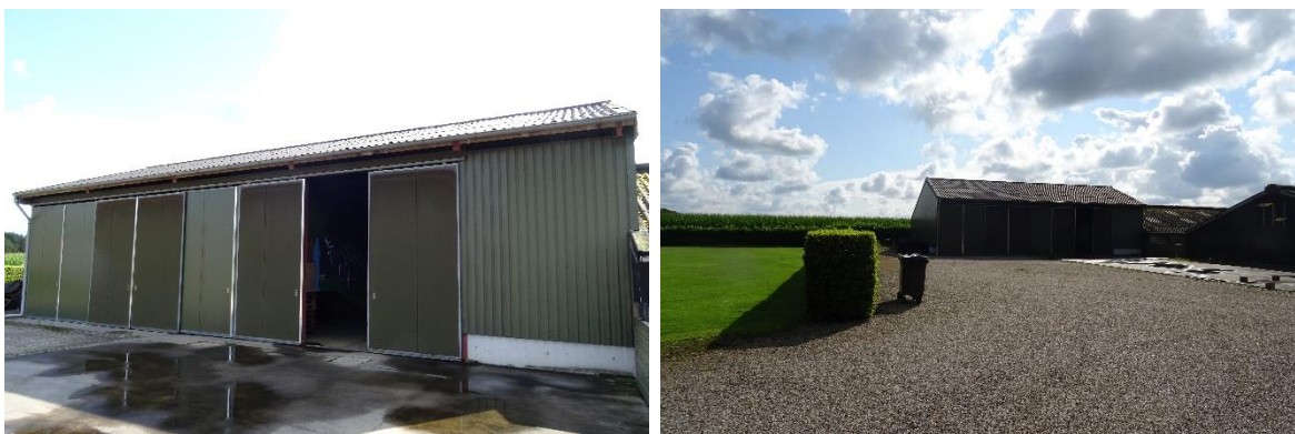
Afbeelding 7 en 8: Aanwezige, mogelijk te verplaatsen, loods. Bron: R.J.L. Bijvelds 02-08-2021
