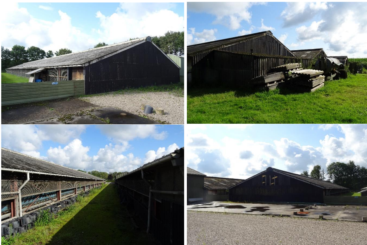
Afbeelding 3 t/m 6: Bestaande (grotendeels) te slopen stallen op de kavel. Bron: R.J.L. Bijvelds 02-08-2021
