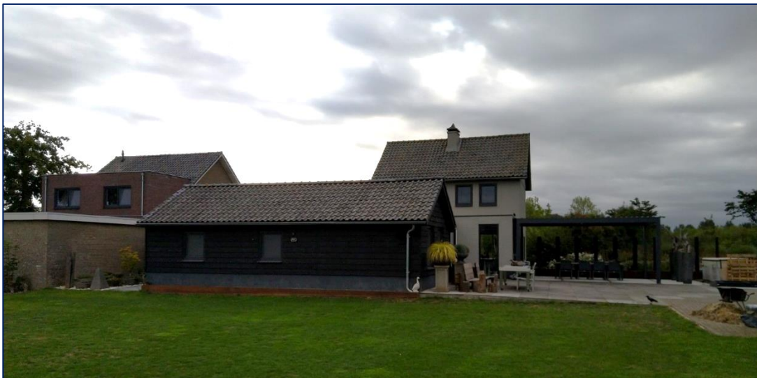
Woning en bestaand aangebouwd bijgebouw Boskamp 16 vanuit achtertuin
