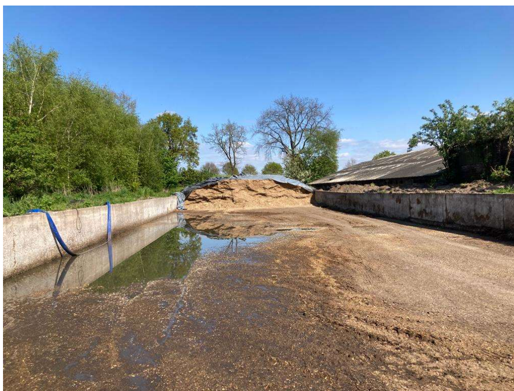
• Afbeelding 17: Te slopen kuilplaat
