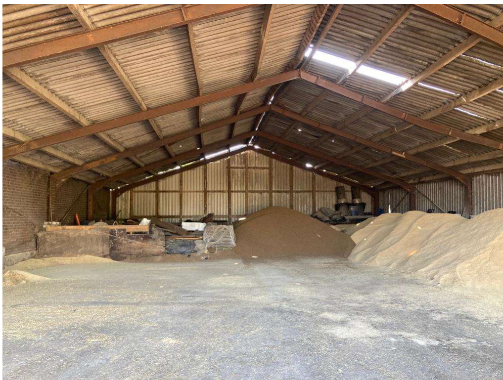
• Afbeelding 16: Te slopen voeropslagloods
