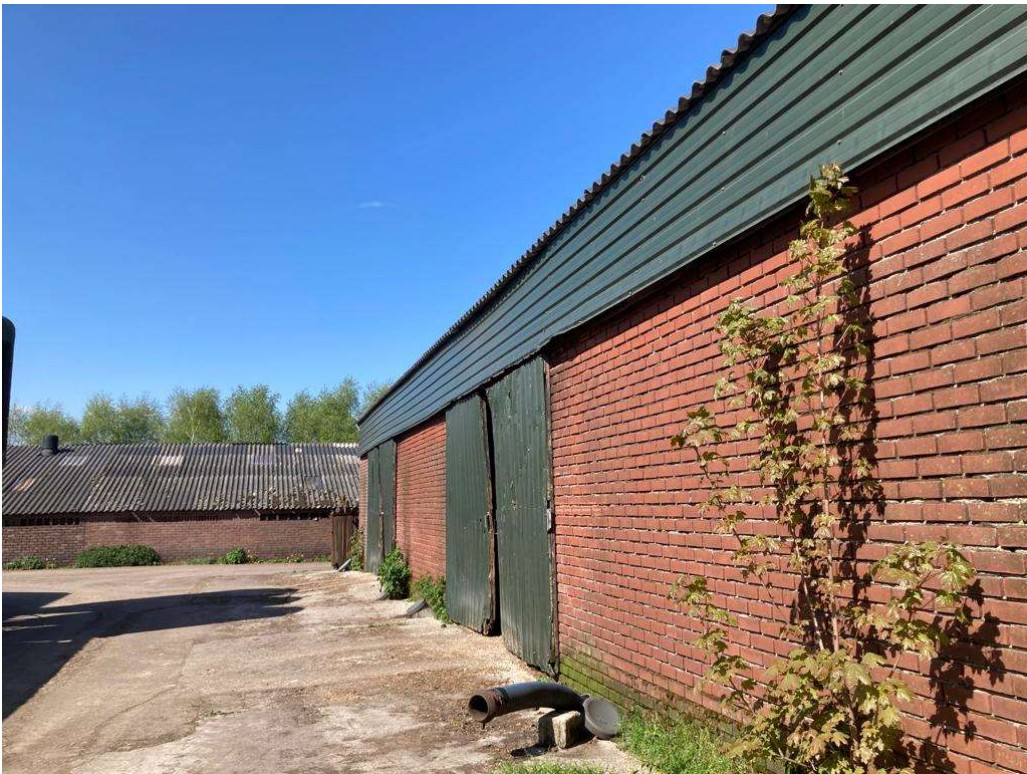
• Afbeelding 9: Te slopen stal
