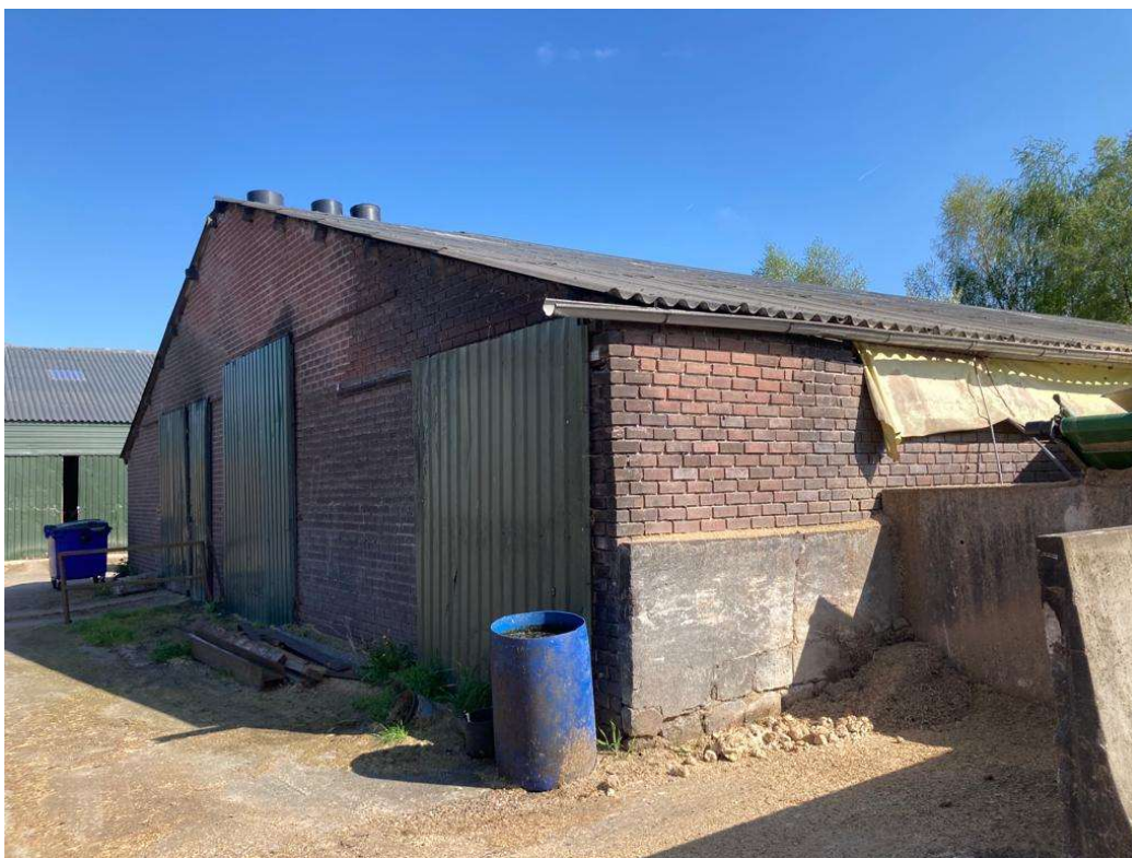
• Afbeelding 12: Te slopen stal
