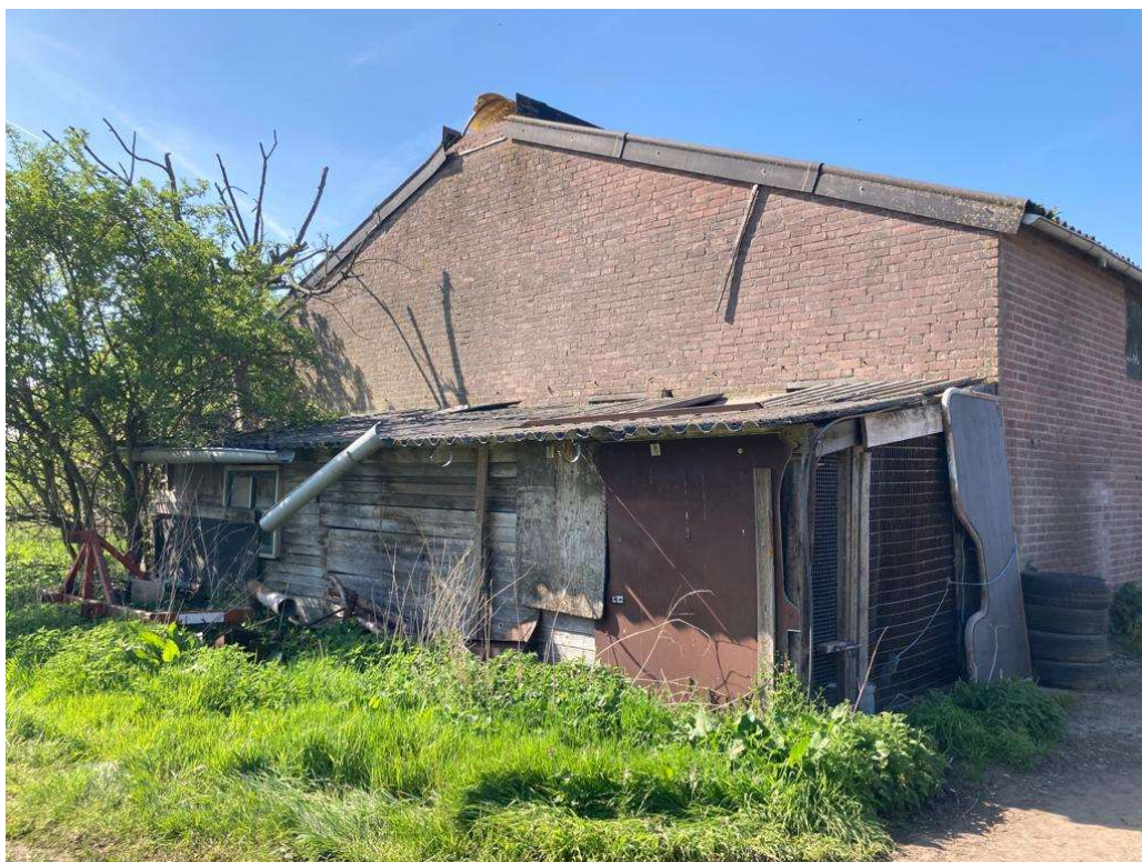
• Afbeelding 6: Te slopen stal met aanbouw en begroeiing
