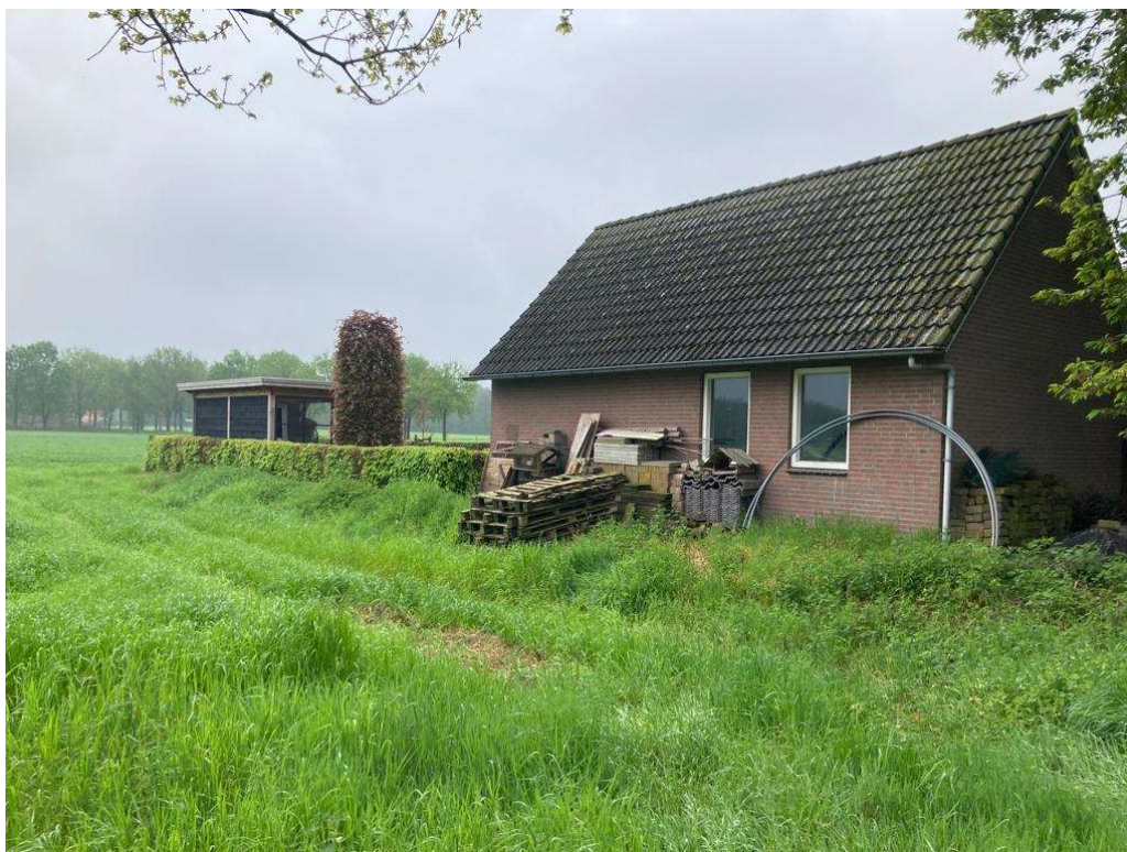
• Afbeelding 14: Achterzijde bijgebouw bedrijfswoning met opslag
