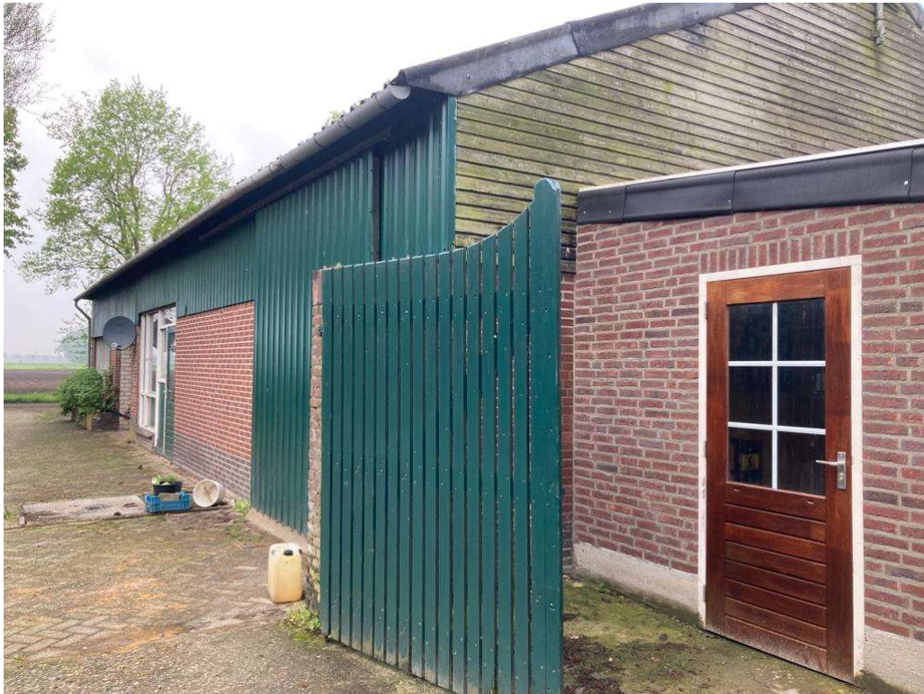
• Afbeelding 6: te verbouwen bedrijfsgebouw
