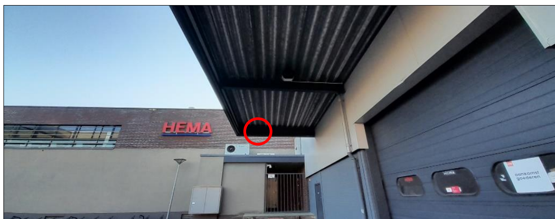
Afbeelding 3.3: Foto van de ingang van één van de gevonden huismussen nesten (rood omcirkeld), een ander nest zat aan de andere kant van dit afdak.
