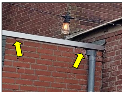
Figuur 15. Ruimtes onder de daktrim en boven de regenpijp.
