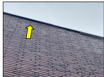
Figuur 25. Ruimte onder de daktrim bij de bebouwing op Hoogkoorpassage 12.
