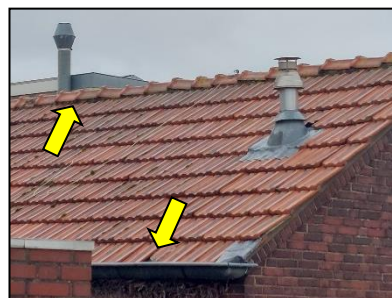
Figuur 16. Ruimtes onder de dakpannen.
