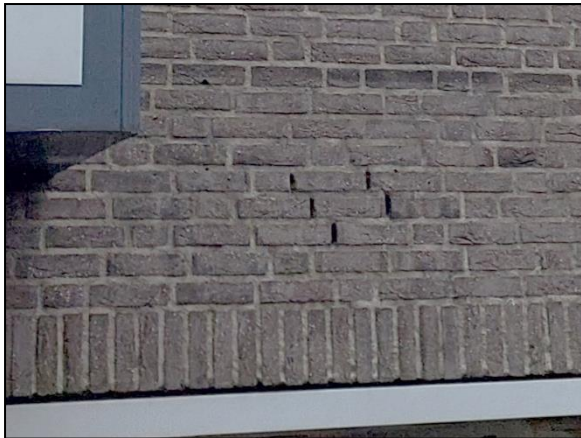
Figuur 17. Openingen in de muur.
