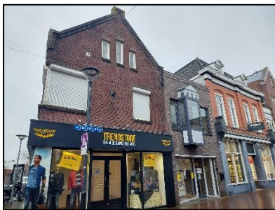
Figuur 4. De onderzoekslocatie (Steenstraat 80 en 82) gezien vanaf de Steenstraat.
