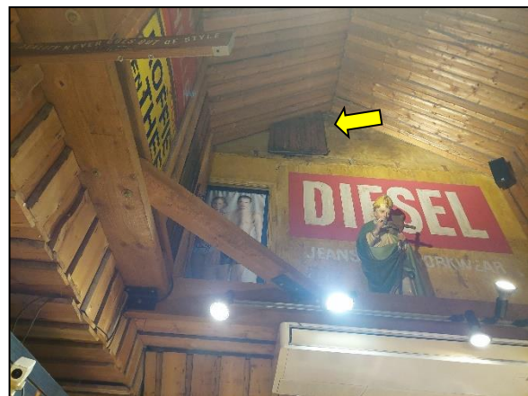
Figuur 20. Mogelijke toegang tot het bovenste deel van de zolder.
