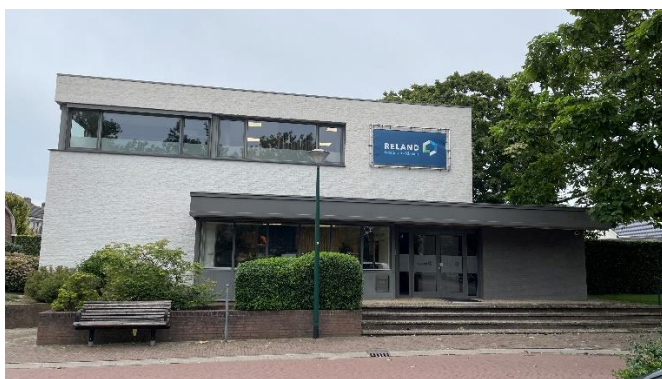
Nadrukkelijke horizontale gevelgeleding (raampartij en luifel)
