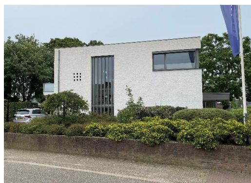
Sobere details: verticale stijlen in het raamkozijn en uitsparingen in metselwerk in rasterpatroon
