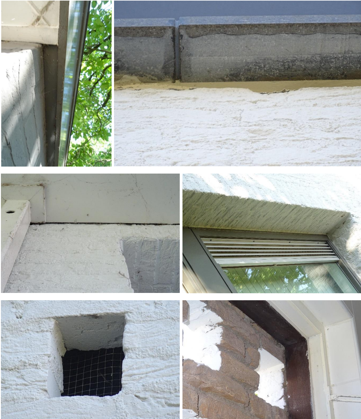
Afbeelding 8 t/m 13: in de te verbouwen bebouwingen zijn geen sporen / mogelijke verblijfplaatsen van vleermuizen aangetroffen. Bron: R.J.L. Bijvelds 08-09-2021
