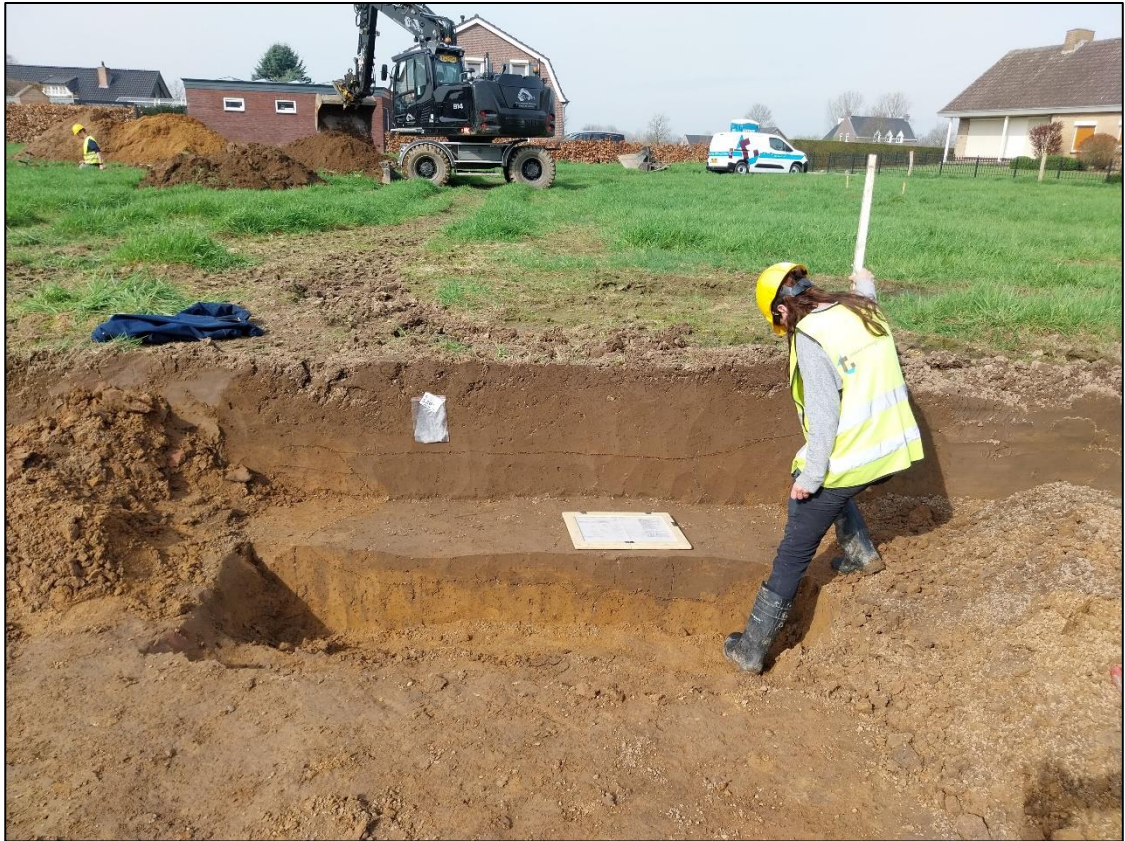
Figuur 2. De aanleg van een coupe en profiel in werkput 2 op 19 maart 2024, aanleg vanuit vlak 1.
