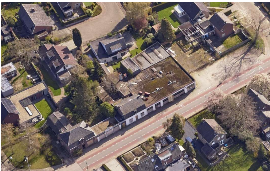
Figuur 6; luchtfoto huidige situatie
