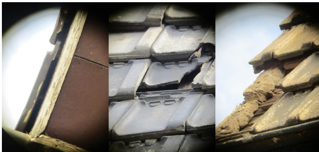
Figuur 4 Kierende kant- en nokpannen en ontbrekende en scheefliggende dakpannen zijn geschikte in- en uitoliegopeningen om door vleermuizen in de bebouwing te komen.
