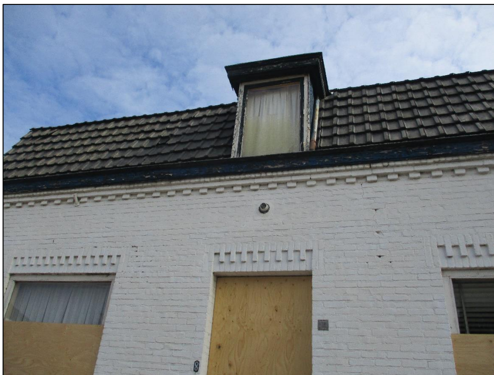
Figuur 3 De westgevel van het bedrijfspand, deze sluit aan op de autogarage.
