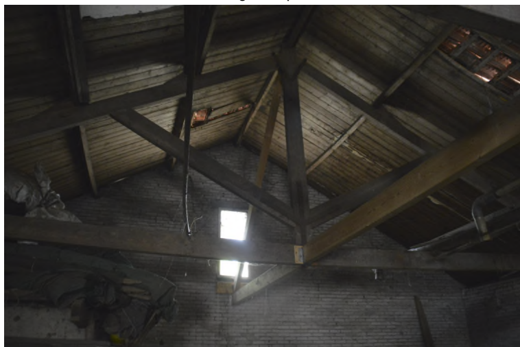
Binnenzijde grote schuur
