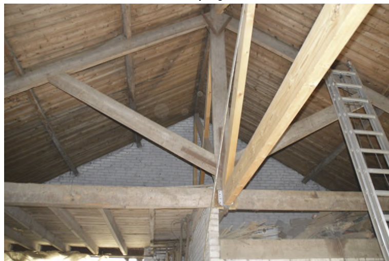
Constructie schuur met dakbeschoot
