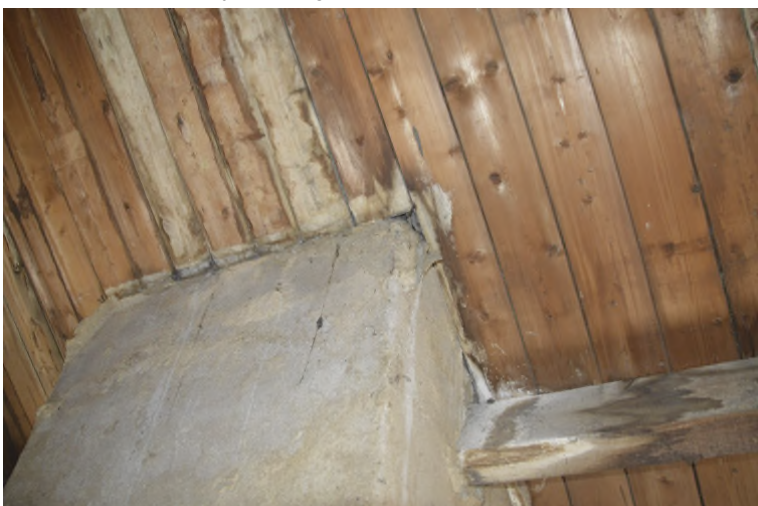
Aansluiting schoorsteen op dak/dakbeschoot
