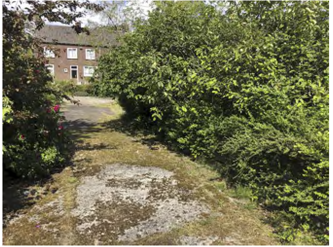
Achterzijde woning vanaf achtertuin
