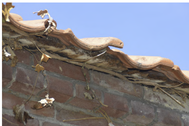
Aansluiting dak op muur van schuur
