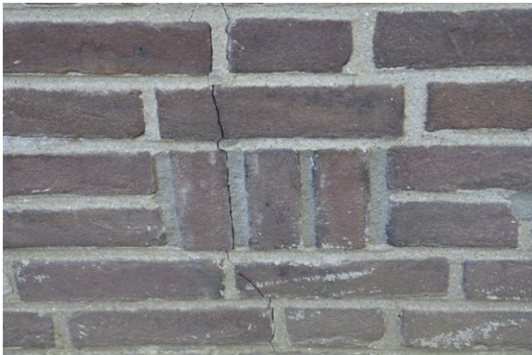
Dichtgemetselde spouwopeningen (vanwege na-isolatie woning)
