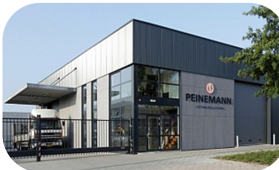
bedrijfshal met open hoek en luifel
