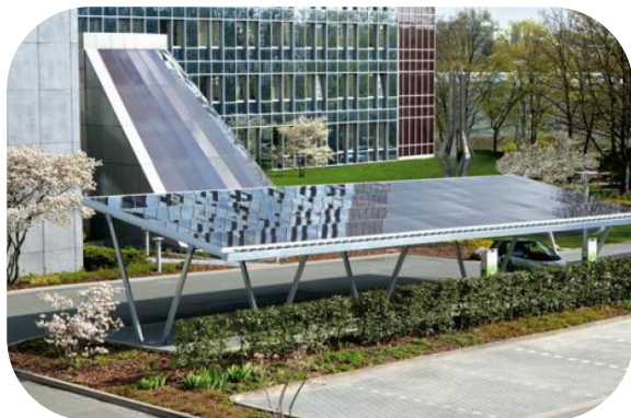
Energie: zonnepanelen boven parkeren
