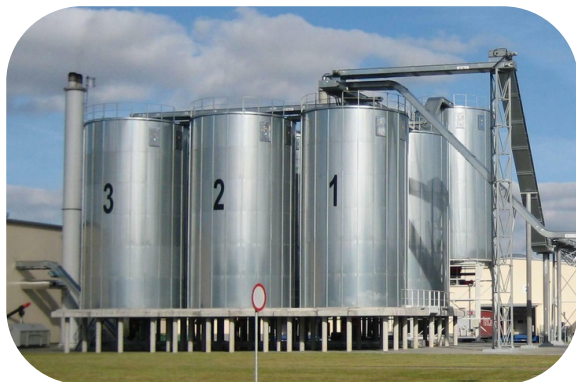
silos en bedrijfsinstallaties
