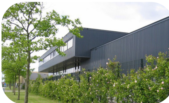
bedrijfshal met kantooropbouw
