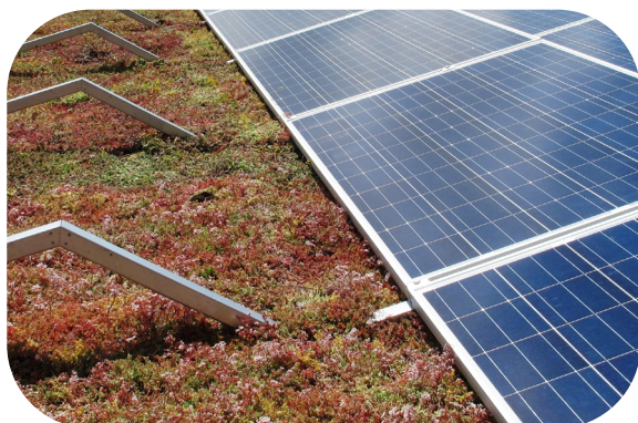
Klimaatadaptatie: sedumdak en zonnepanelen
