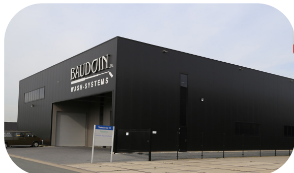
open gevel bij entree
