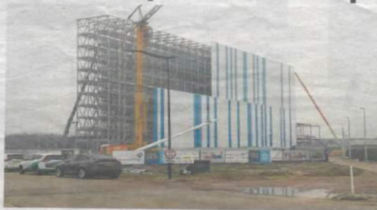
Nieuwbouw van transportbedrijf Coenen op Bedrijvenpark Laarakker.
