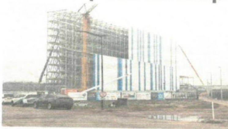
Nieuwbouw van transportbedrijf Coenen op Bedrijvenspark Laarakker.
