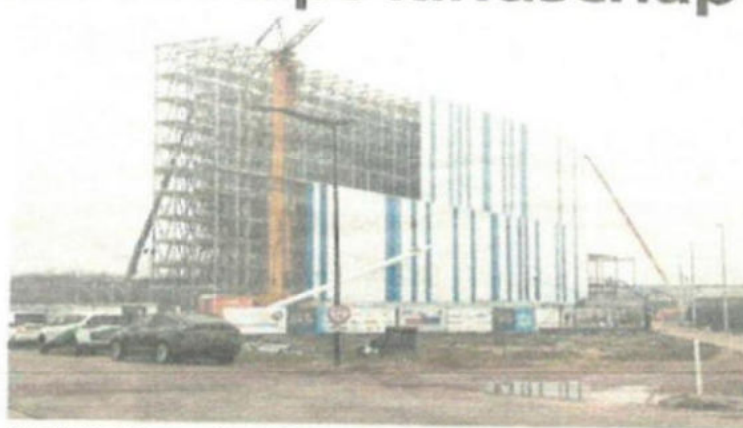
Nieuwbouw van transportbedrijf Coenen op Bedrijvenpark Laarakker.
