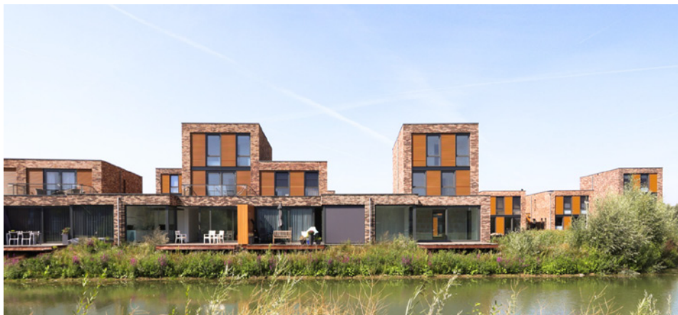
referentiebeelden architectuur woningen oeverzijde
