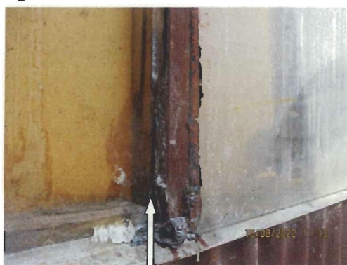
Asbesthoudende beglazingskit (M01); detailfoto en plaats.
