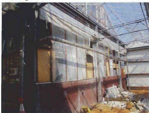
Overzichtsfoto's wand voorzien van asbesthoudende beglazingskit (circa 30 m 2 ).
