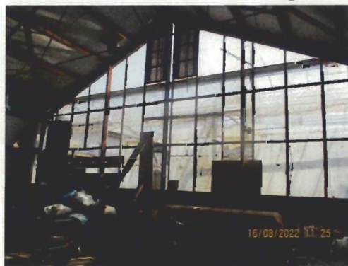
Overzichtsfoto's wand voorzien van asbesthoudende beglazingskit (circa 30 m 2 ).
