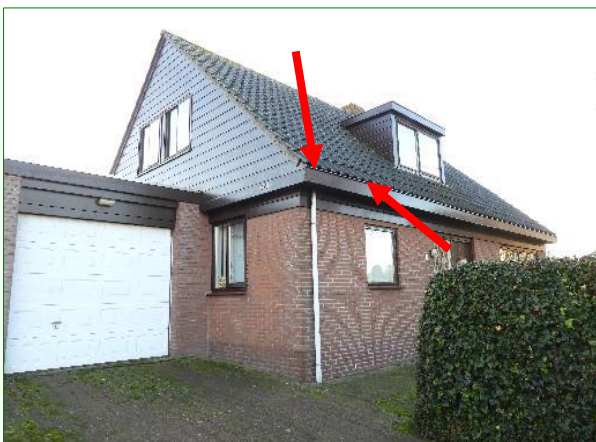
De openingen onder de dakpannen en bij het dakkapel geven mogelijk toegang tot voor Huismussen geschikte achterliggende ruimtes.
