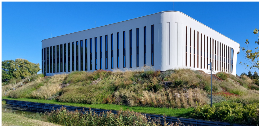
monoliet met plastische gevel door verticale geleding
