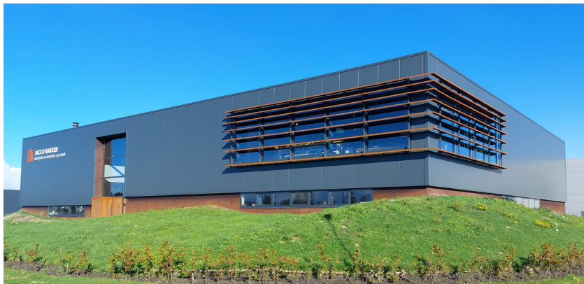
gebouw als monoliet op De Vaandel Midden
