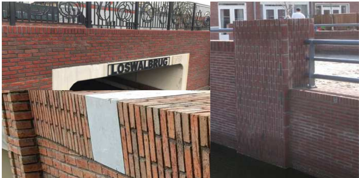
Opgemetselde landhoofden met verbijzonderingen in het metselwerk.
