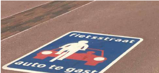
toegepaste verhardingen fietsstraat asfalt + gebakken klinkers
