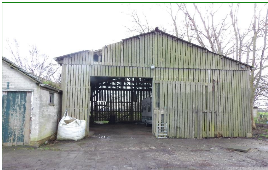
De te slopen schuur in het plangebied, met links de aansluitende bebouwing.
