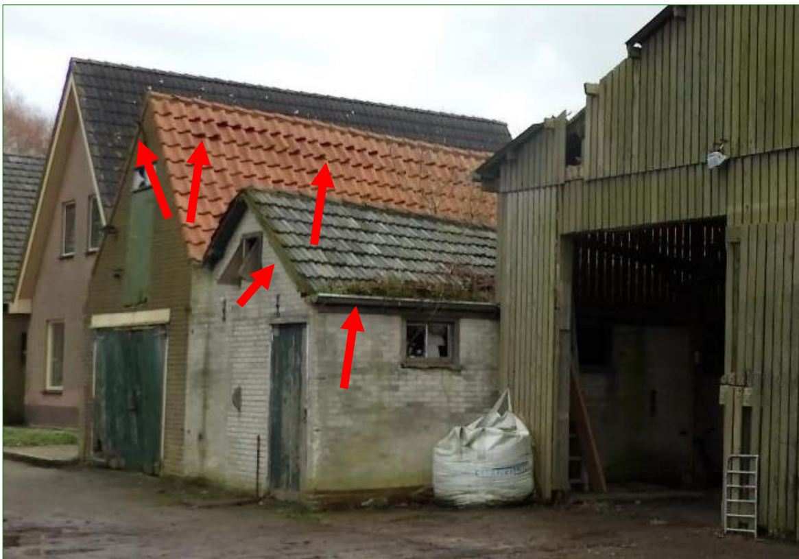
De openingen in de direct naastgelegen gebouwen (rode pijl) aan de oostzijde van de te slopen schuur geven mogelijk toegang tot voor vleermuizen geschikte achterliggende ruimtes.
