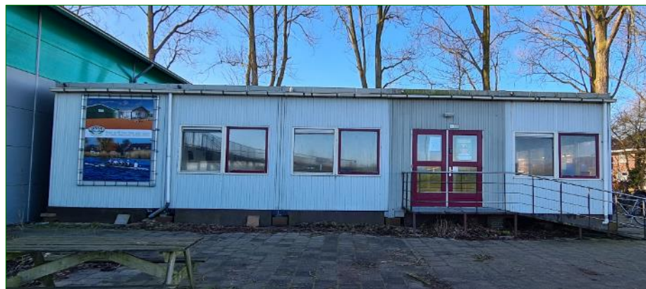
Impressie van twee gebouwen; een opslagplaats (boven) en de te slopen bebouwing (onder).
