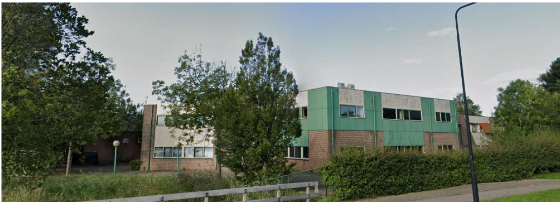
Afbeelding 2.1: Foto huidige situatie (noordwestzijde)
