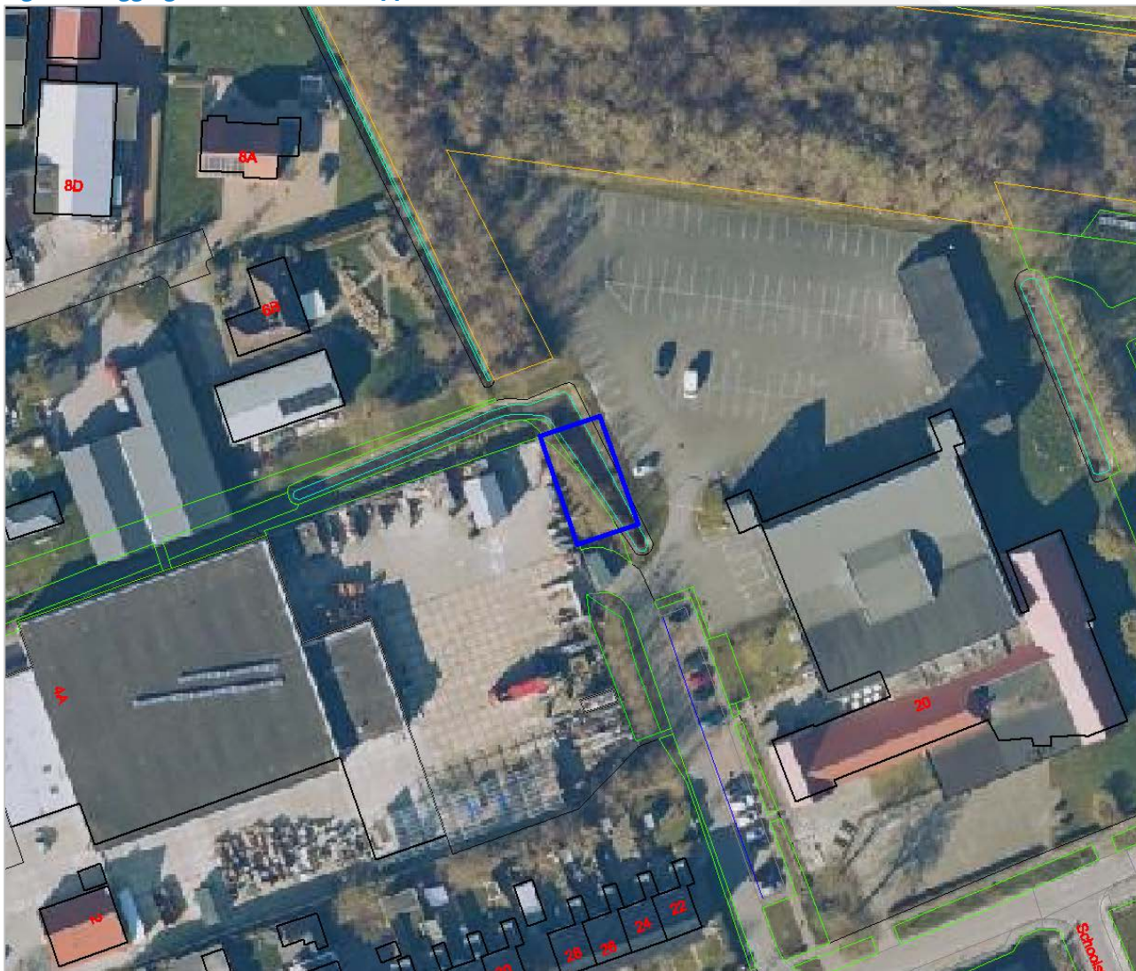
Figuur 1: Ligging warmtecentrale Loppersum
