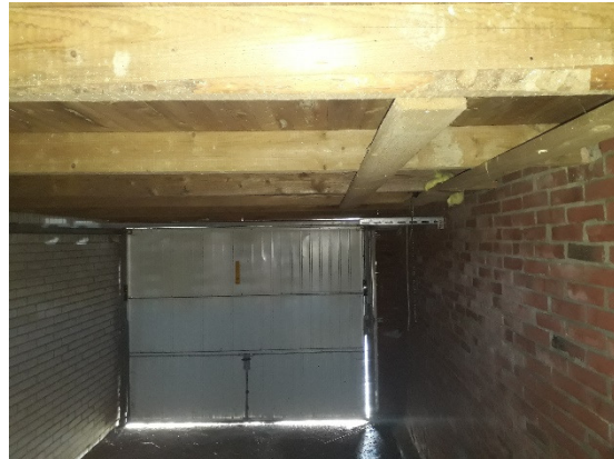
Figuur 2.26: Foto van de binnenkant via opening in garagebox.
