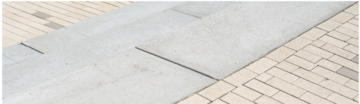
Overloop betontegels naar betontrappen.
