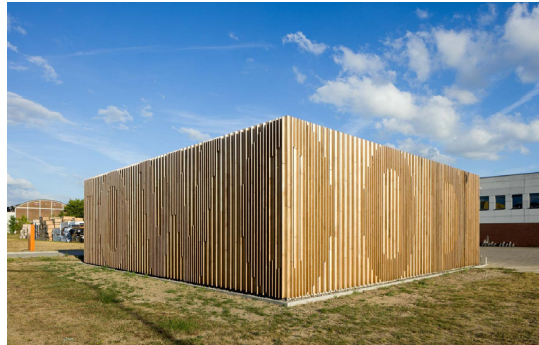
Naam van het restaurant in de gevel.
