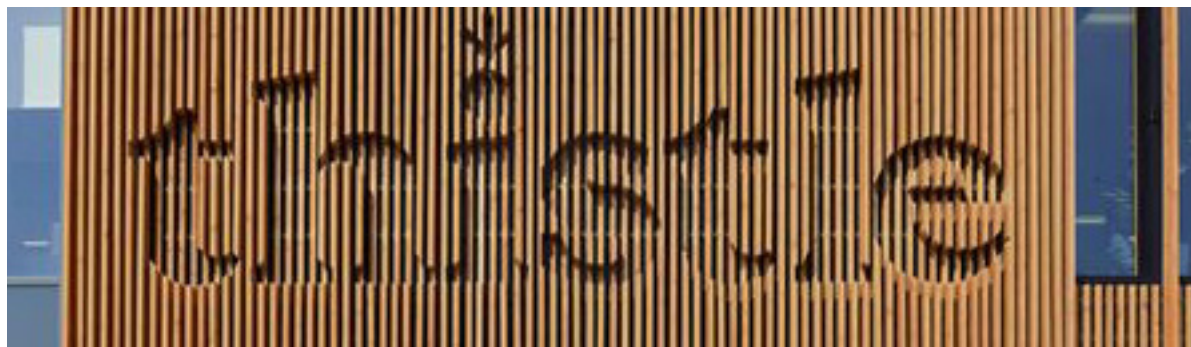
Naamgeving in de gevel verwerkt.
