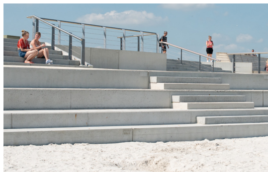
Tussenniveau verbonden met trappen.
