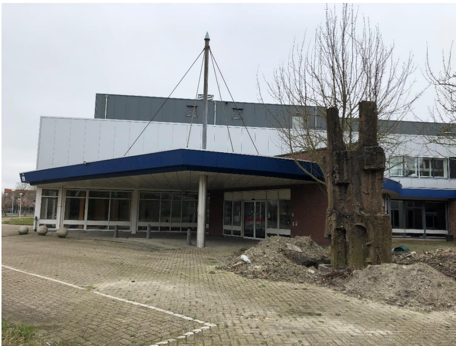
Figuur 3- Het plaatwerk bij de ingang van het ziekenhuis vormt een gesloten geheel. Hier zijn geen aanvullende maatregelen i.h.k.v. het ongeschikt maken nodig.
