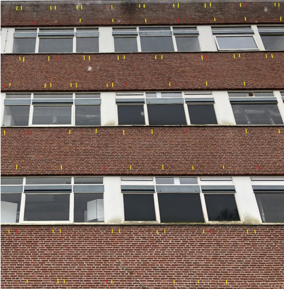
Figuur 1- Voorstel voor de globale plaatsing van de exclusion flaps . Geel= open stootvoeg dichtzetten, rood= plaatsing exclusion flap.
