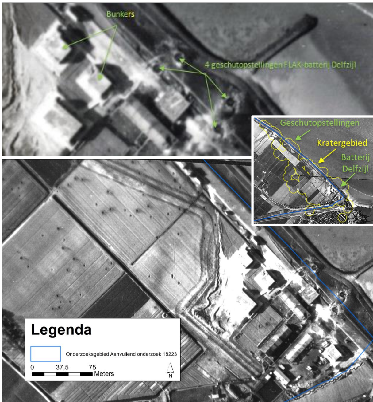
Figuur 12: Sporen van geallieerde artilleriebeschieting op de FLAK-batterij Delfzijl op luchtfoto van 26 april 1945
