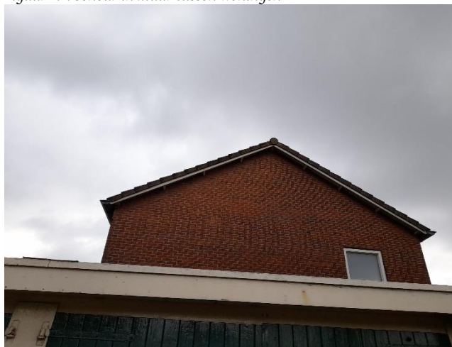
Figuur 4.3: Ruimten onder kantpannen
