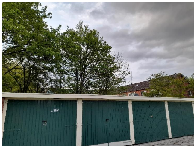
Figuur 4.5: Vochtige openingen in houten dak betimmering
