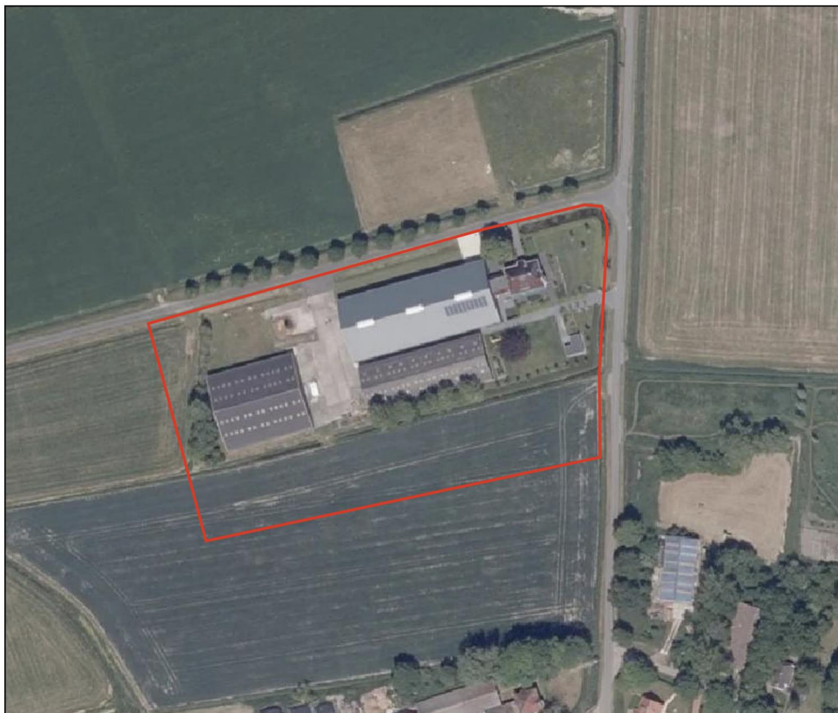
Afbeelding 2.1 Luchtfoto huidige situatie plangebied (Bron: Google maps)
