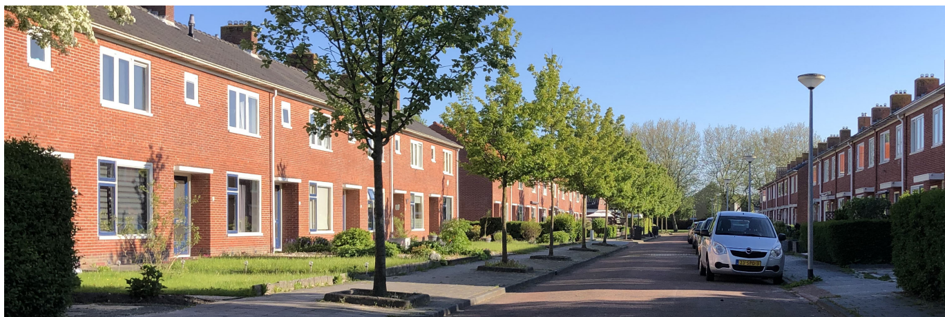
Foto van de huidige woningen in de Placiusstraat
