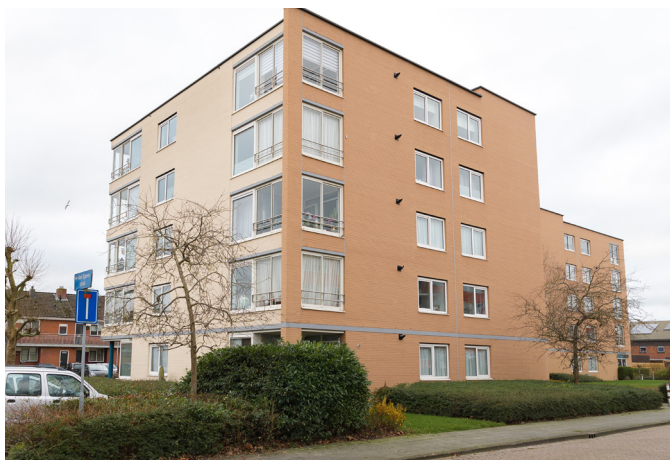
Bestaande Urban Villa’s vanaf Nicolaas Westendorpstraat
