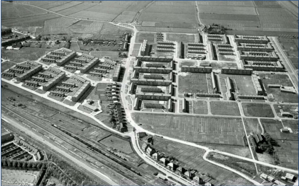
Figuur 7: Foto van de bouw van de Zanden en Riffenbuurt (bron: Groninger Beeldbank).
