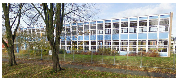
Foto van het voormalige schoolgebouw net voor de sloop.
