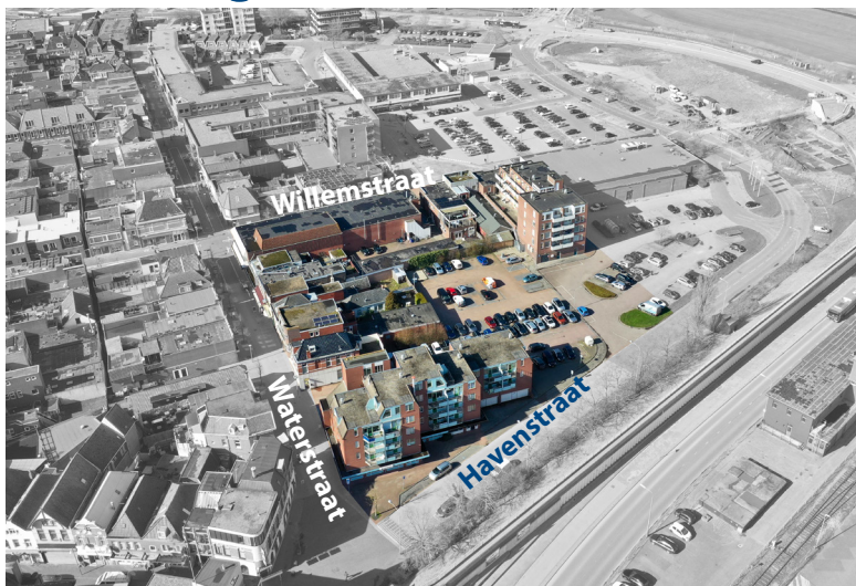
Luchtfoto plangebied De Courtine tussen de Willemstraat, Waterstraat en Havenstraat
