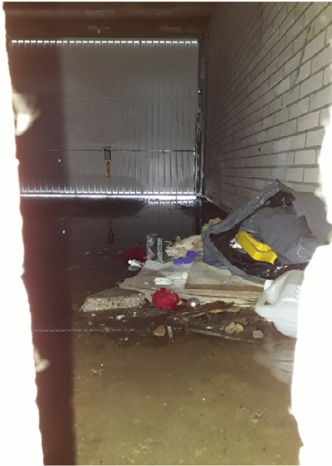
Figuur 2.25: Foto van de binnenkant via opening in garagebox.
