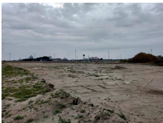
Figuur 2.17: Bouwterrein met opgebracht zandpakket (noordzijde).
