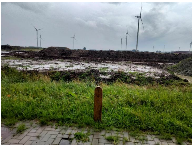
Figuur 2.5: Impressie berm langs de Kloosterlaan, met aan de achterzijde een bouwterrein (oostzijde plangebied).
