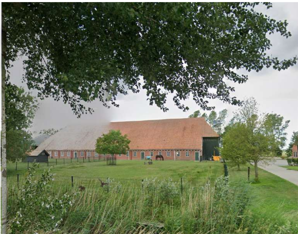
Figuur 2.2 Aanzicht monumentale korenschuur (bron: Google Maps)
