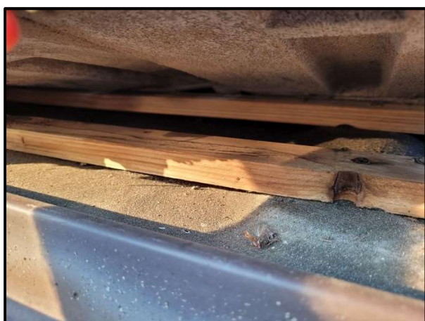
Links: Geen sporen van natuurwaarden onder de dakpannen.
