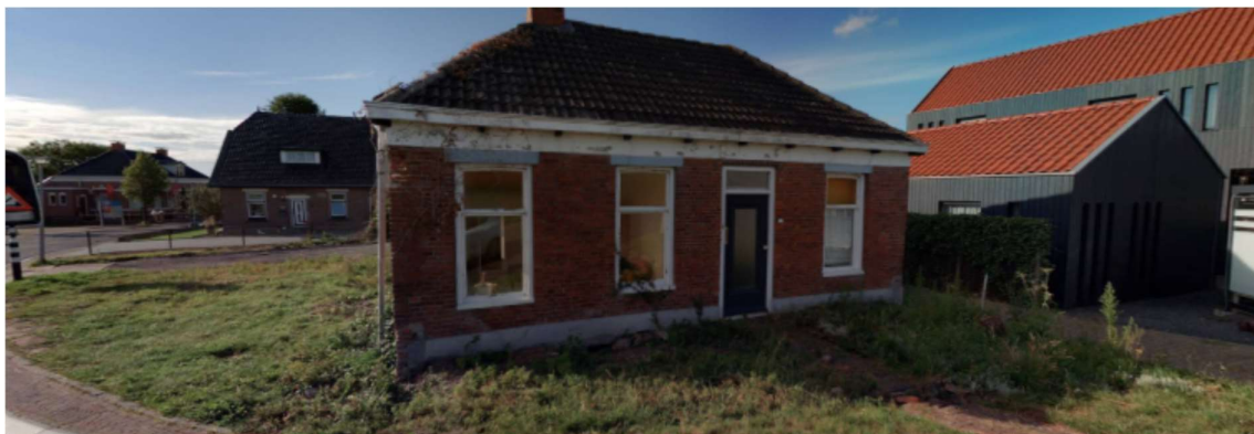
Figuur 5 Foto plangebied met reeds gesloopte woning nog aanwezig.
