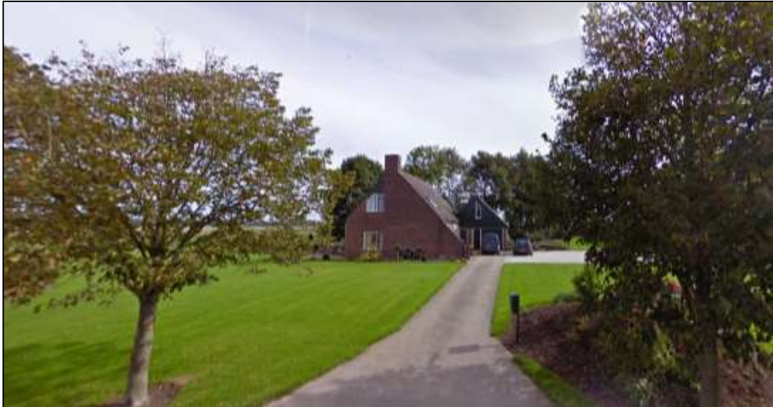
Figuur 5 Bestaande woning
