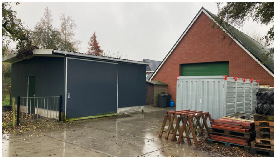
bestaande opslaggebouw met daarvoor schapenstal en opgeslagen materiaal
