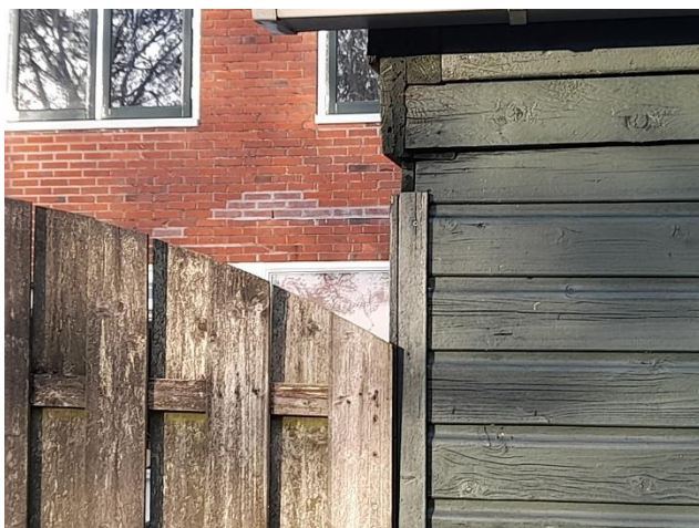
FOTO 7: ACHTERKANT BOUWMASSA MET OPEN STOOTVOEG
