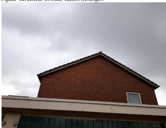
Figuur 4.3: Ruimten onder kantpannen
