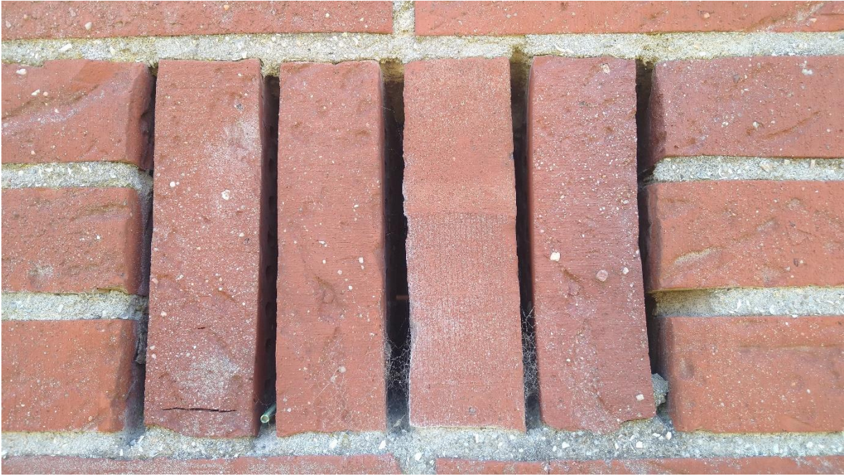
Figuur 2.3. Een stootvoeg in de oostelijke muur van de garageboxen.
